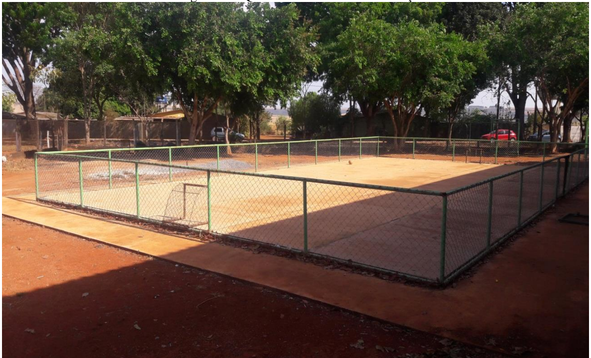
Fotografia 3 - Quadra de voleibol em construção
