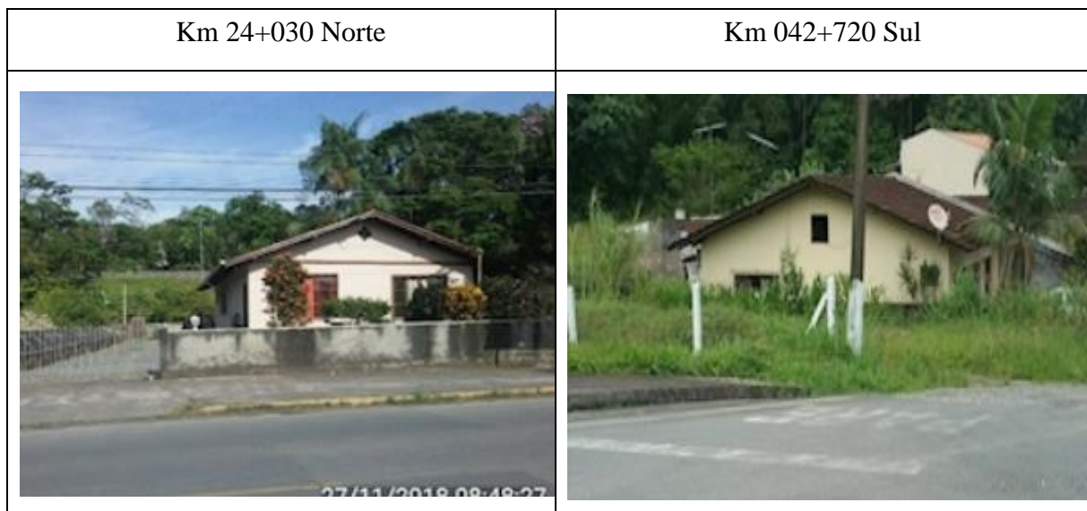
Figura 4-5: Exemplo de ocupações irregulares do tipo residencial Fonte: Autopista Litoral Sul (2019).
