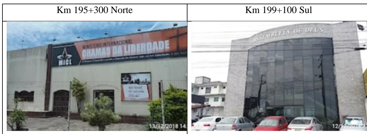
Figura 4-9: Exemplo de ocupações irregulares do tipo outros Fonte: Autopista Litoral Sul (2019).
