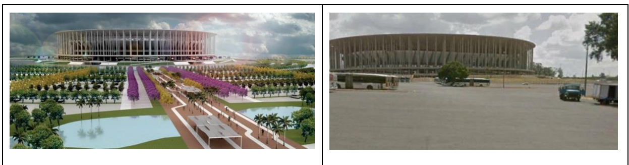
Figura 18 – Estádio Mané Garrincha com piso impermeabilizado.
