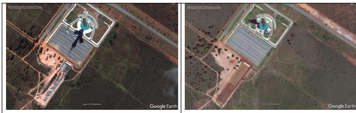
Figura 35 – Bacia de retenção da Torre de TV Digital.
