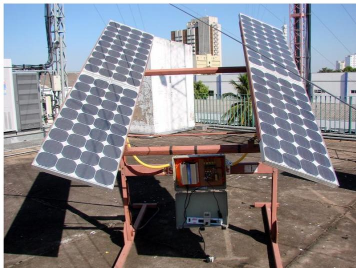
Figura 4.21 - *Instalação completa do módulo de controle CC, conversores GRID TIE, medidor de energia.*
