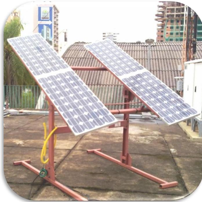
Figura 3.23 - Suporte com quatro painéis solares Siemens SP-75.
