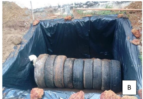
FOTO 8: Lona para impermeabilizar o sistema (A) e câmara de pneus posicionada (B).
