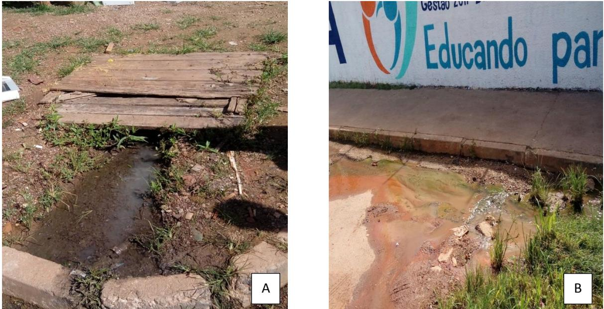
FOTO 1: Fossa extravasando (A) e esgoto correndo na entrada da escola (B).
