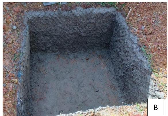
FOTO 6: Tela fixada nas paredes do Tanque (A) e paredes chapiscadas (B).
