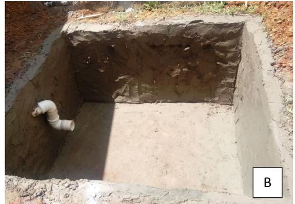
FOTO 7: Paredes e piso do Tanque rebocada (A) e encanação instalada (B).
