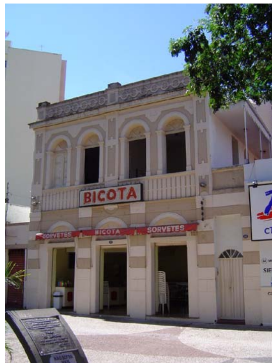
Figura 53 (à direita) – Sorveteria Bicota e residência, na Praça Rui Barbosa (agosto de 2004)
