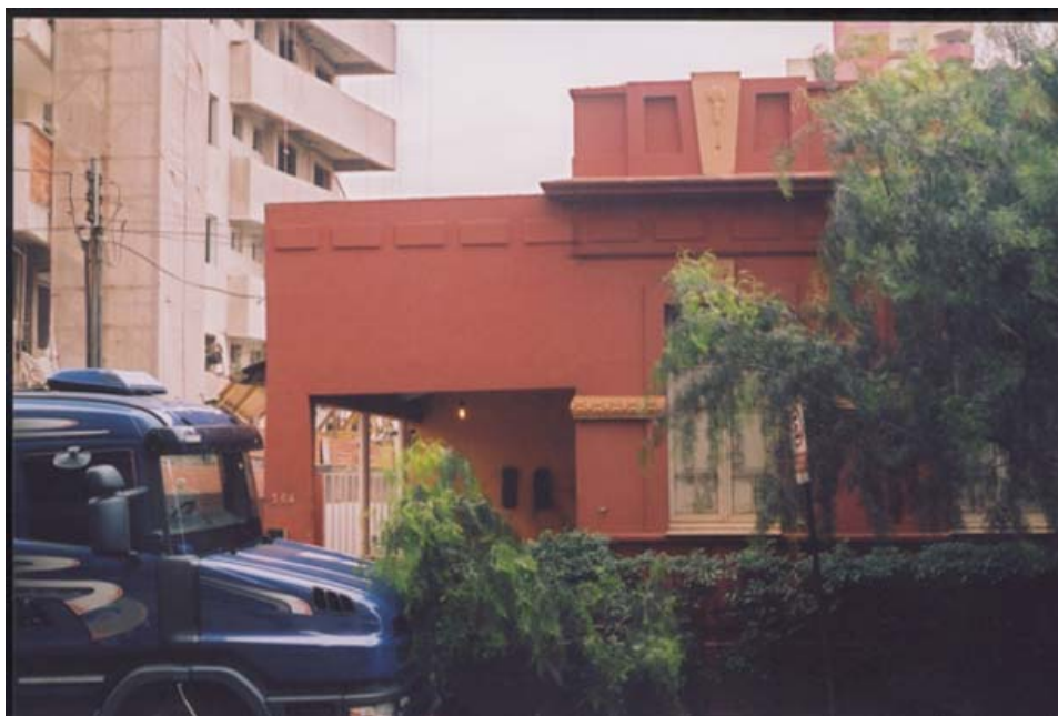
Figura 87 – Casa na rua 15 de Novembro, demolida em março de 2004 (2003)
