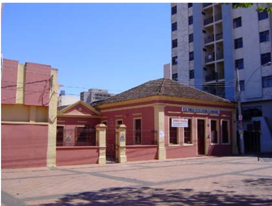
Figura 97 – Escola Estadual Enéas de Oliveira Guimarães, imóvel indicado para tombamento integral no Inventário do Fundinho (Vale et alii, 2004b) (abril de 2004)
