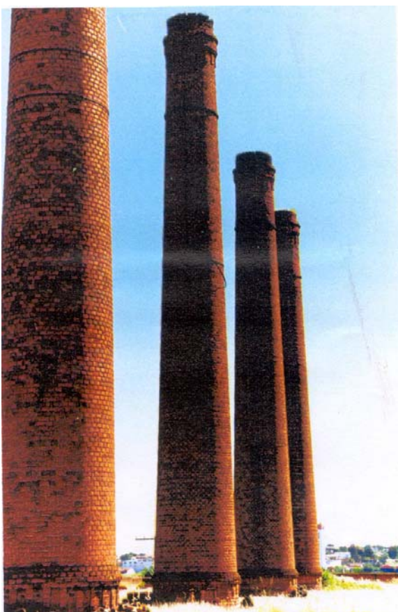
Figura 67 – Chaminés da Cerâmica Uberlândia (fevereiro de 2003)
