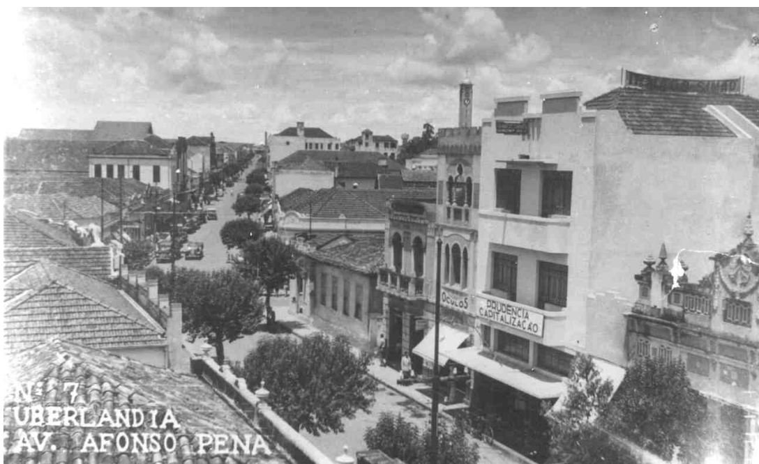
Figura 61 – Edifício Naguettini, construído entre 1925 e 1927 (sem data)
