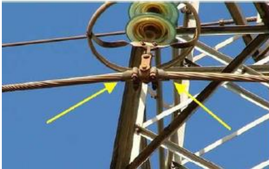
Figura 1.4: Detalhe do grampo de suspensão que fixa o cabo à torre (EPRI, 2006).
