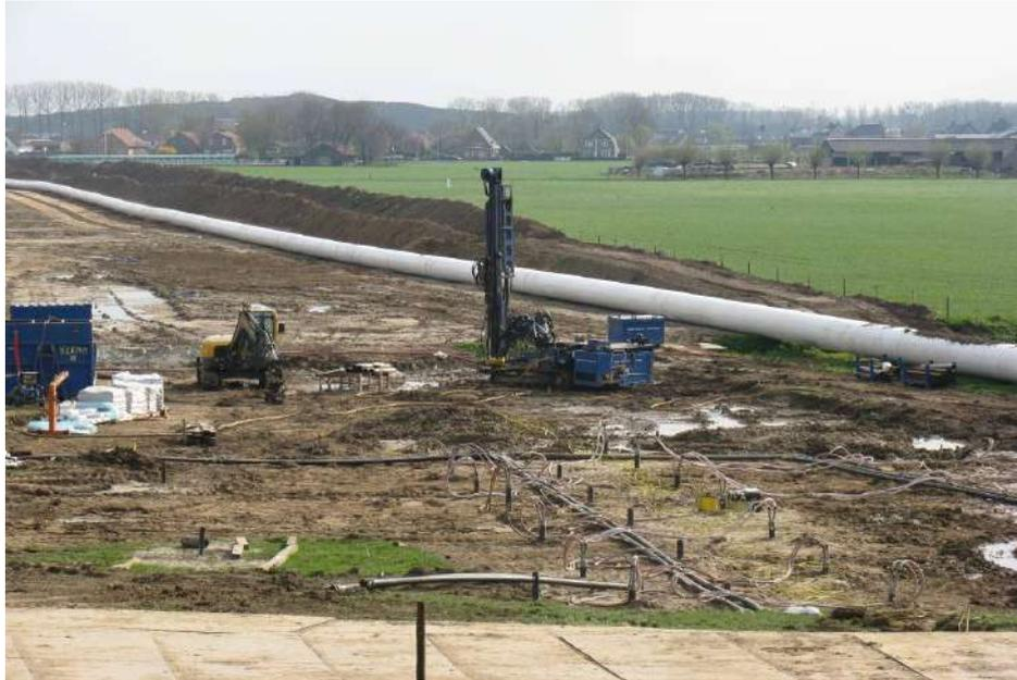
Figura 2-25. Primeira aplicação do *biogROUT*. cimentação de cascalho para estabilidade de perfurações horizontais. No primeiro plano, 6 poços de injeção, cercados por 14 poços de extração, foram instalados em uma área de 24 por 4 m. (Van Paassen, 2011).
