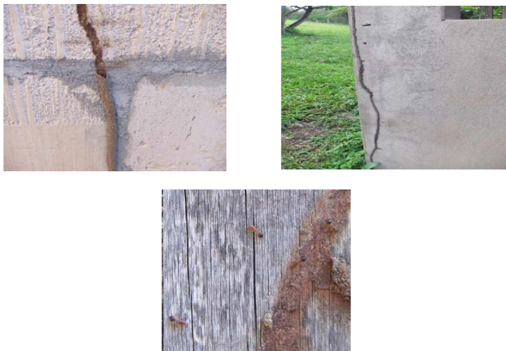
Figura 2.18 - Galerias e fezes de cupins de madeira seca. (MELO,2014)
