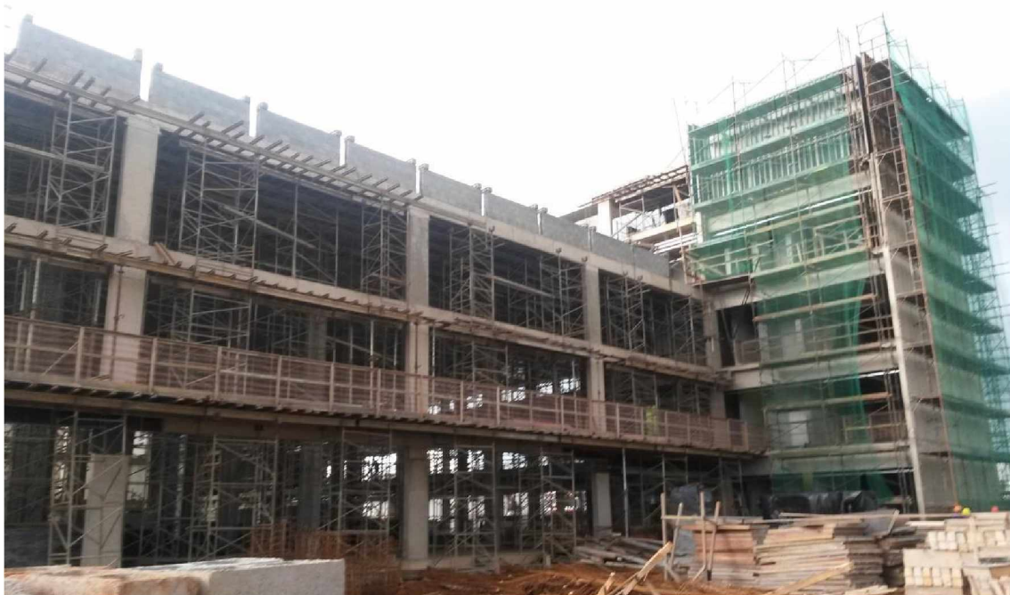
Figura 4-34 – Obra em março de 2016.
