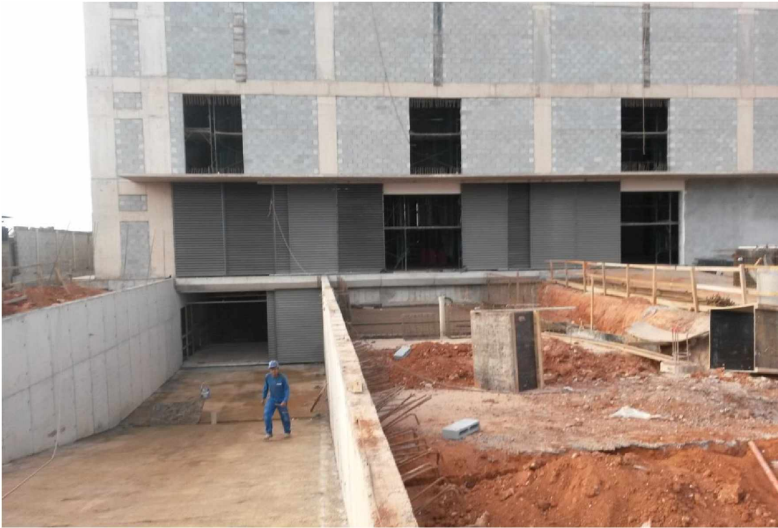
Figura 4-35 – Obra em junho de 2016. Fonte: Câmara dos Deputados (2018).
