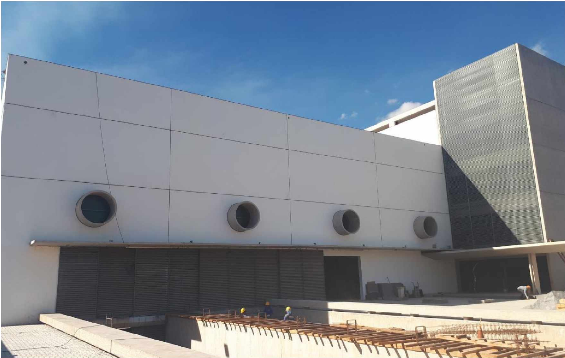
Figura 4-37 – Obra em junho de 2017. Fonte: Câmara dos Deputados (2018).
