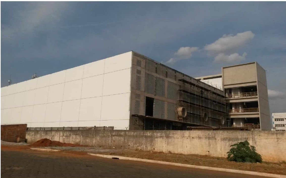
Figura 4-36 – Obra em setembro de 2016. Fonte: Câmara dos Deputados (2018).
