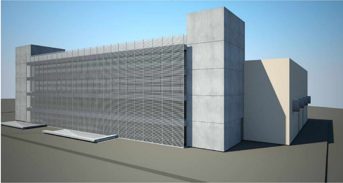
Figura 4-23 – Perspectiva externa do edifício CEAM/SIA.
