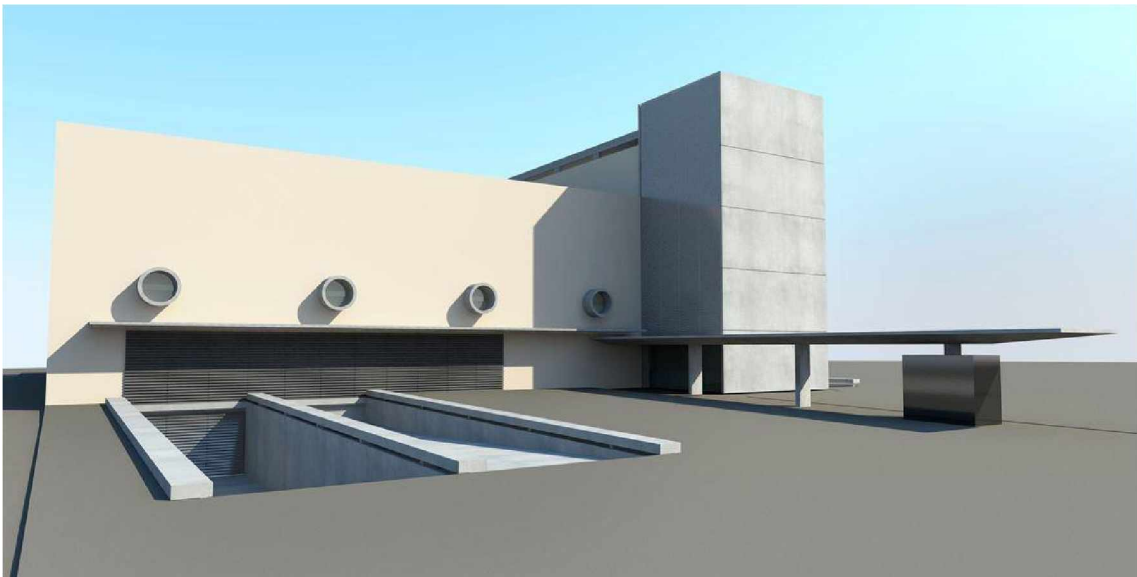
Figura 4-24 – Perspectiva externa do edifício CEAM/SIA.
