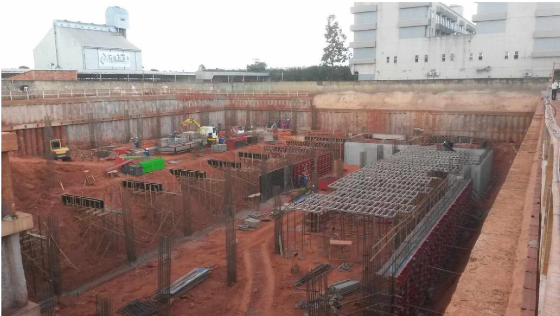
Figura 4-29 – Obra em janeiro de 2015.
