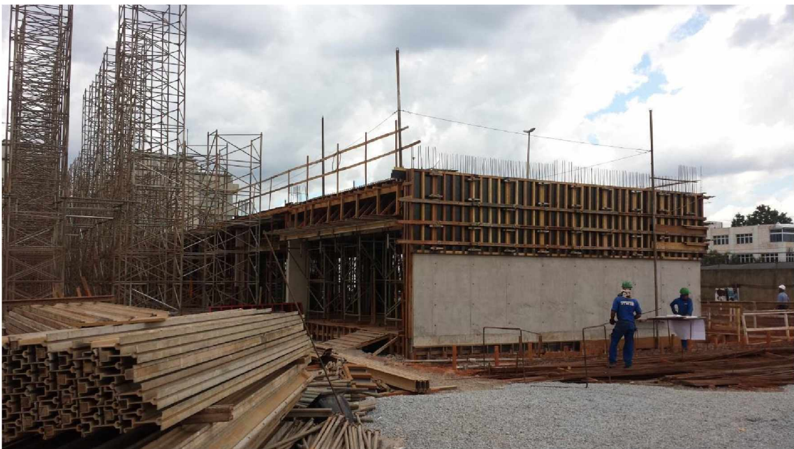
Figura 4-31- Obra em maio de 2015. Fonte: Câmara dos Deputados (2018).
