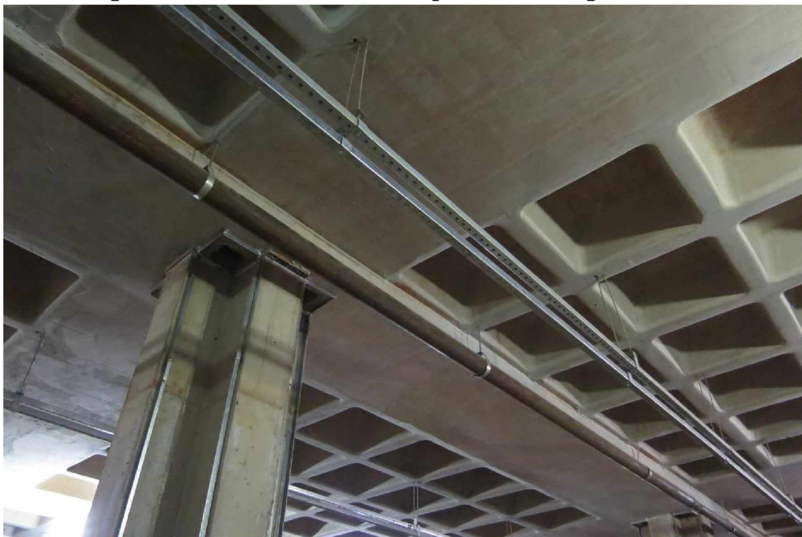
Figura 4-33- Obra em maio de 2015.
