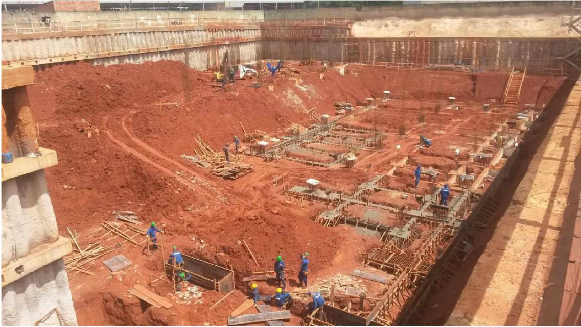
Figura 4-28 – Início da obra em dezembro de 2014.
