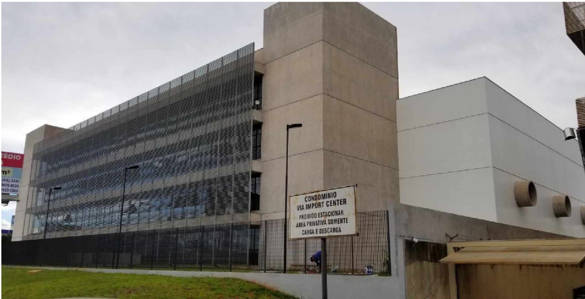
Figura 4-43 – Obra em abril de 2018.
