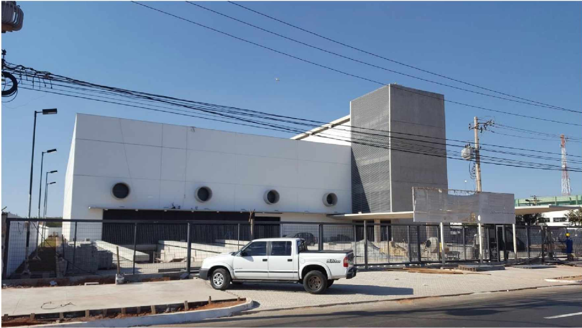
Figura 4-39 – Obra em agosto de 2017.
