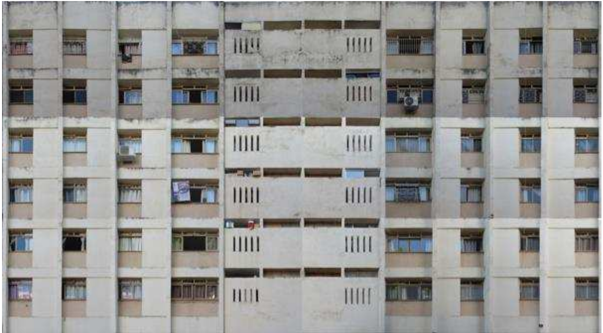
Figura 4.9 – Fachada ortogonalizada de um edifício
