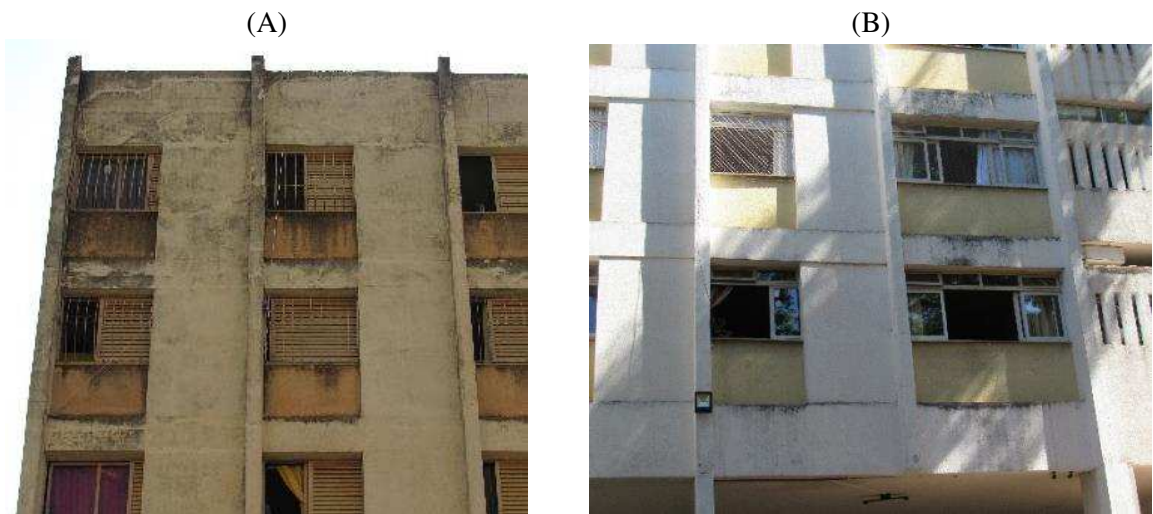
Figura 4.6 – Fotos de uma fachada, obtidas em horários diferentes. (A) Foto sem incidência direta do sol; e (B) Foto com incidência solar direta
