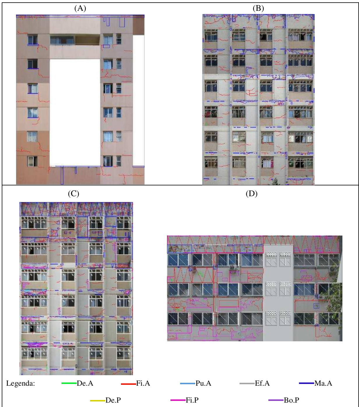
Figura 5.6 – Amostras seleccionadas pertencentes à cada nível de degradação: (A) A1.PL3 - nível 1; (B) A3.PO7 - nível 2; (C) A4.PN3 - nível 3; e (D) A6.PS3 - nível 4
