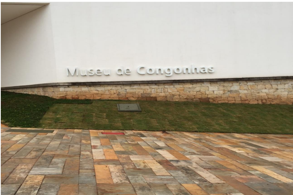
Figura 7- Vista frontal do Museu de Congonhas. Registro em dezembro de 2015.
