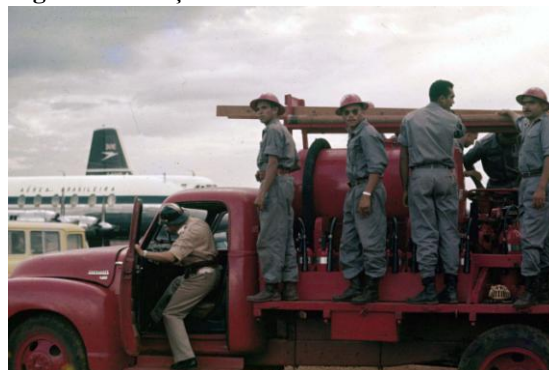
Figura 04 – Seção de combate a incêndios da GEB.
