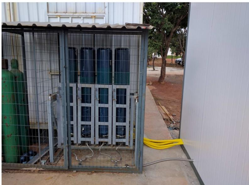
Figura 19: Vista do sistema de acondicionamento de oxidante e dos contêineres de controle (ao fundo) e de testes (à direita)
