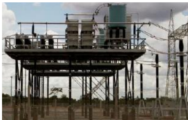
Figura 3.3. Fotografia de uma CSF instalada (OLIVEIRA, 2007).
