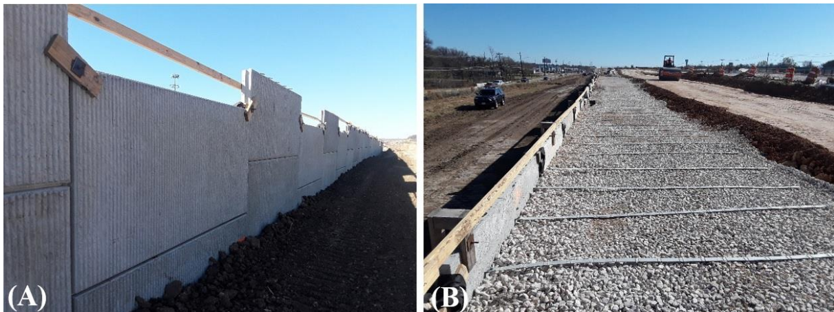
Figura 2.1. Muro de solo mecanicamente estabilizado em construção em Forth Worth – Texas ( Texas State Highway 199 ), (A) paramento externo pré-fabricado de concreto e (B) tiras metálicas com ressaltos.
