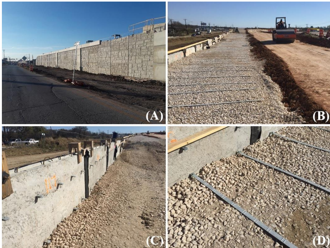
Figura 2.2. Muro de terra armada em construção em Irving – Texas ( Airport Fwy ), (A) Paramento externo de concreto, (B) tiras metálicas com ressaltos, (C) elementos de conexão e (D) detalhe da conexão das tiras metálicas.
