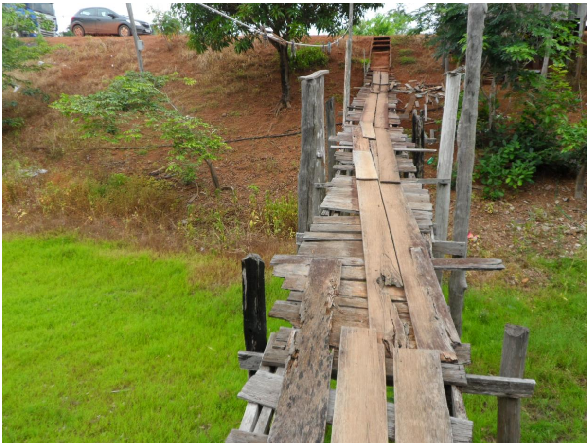
Figura 14. Ponte de acesso à comunidade pesqueira às margens da Rodovia. (Foto tirada pelo autor em nov/2017)
