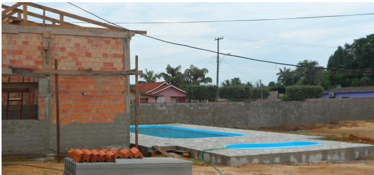
Figura 15. Construção de salão e piscina. (Foto tirada pelo autor em nov/2017)
