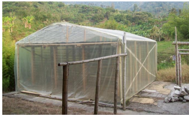
Figura 40 - Processo de secagem solar passiva na Colômbia. Foto: Autor (2010).
