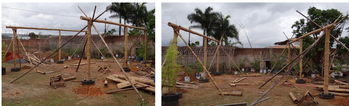
Figura 91 - Processo de levantamento dos pórticos laterais. Fotos: Autor (2011).
