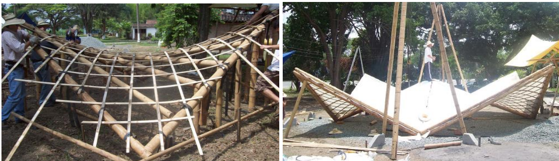
Figura 20 - Estrutura com bambu cilíndrico e ripas de bambu realizada durante o curso de Jorg Stamm, Colômbia (2010). Foto: Autor (2010).
