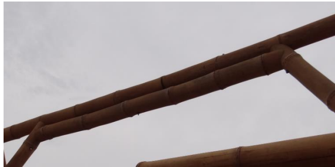
Figura 98 – Detalhe travamento e duplicação de peça na viga principal. Fotos: Autor (2011).
