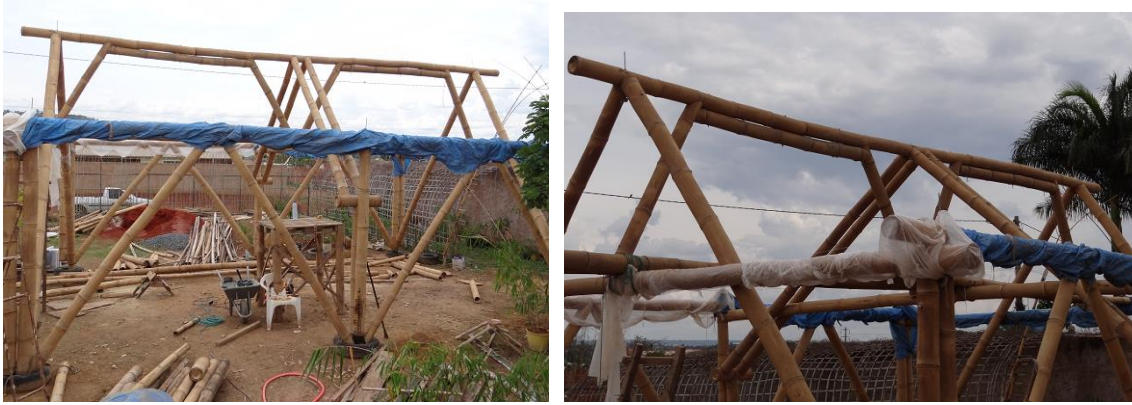
Figura 97 - Travamentos e duplicações de peças na viga principal. Fotos: Autor (2011).
