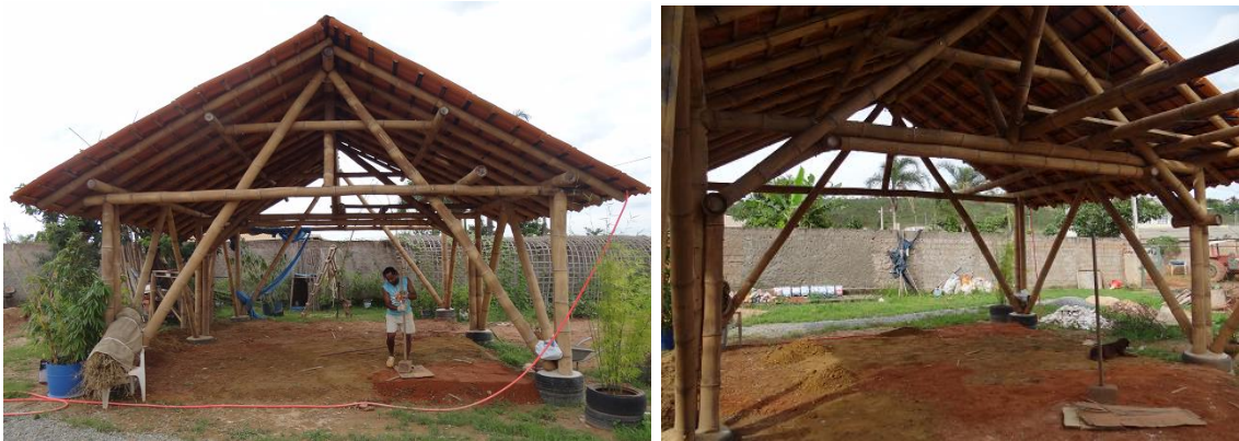
Figura 102 - Nivelamento e compactação do piso da estrutura. Fonte: Autor (2011).
