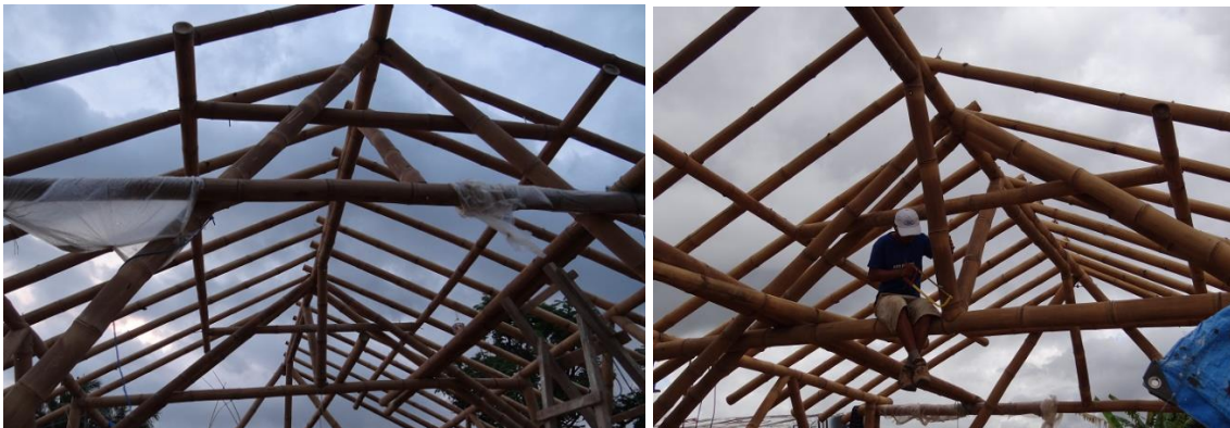
Figura 104 – Figura 104a: Peças de reforço da cobertura. Figura 104b: Peça de reforço aparafusada no pórtico principal. Fotos: Autor (2011).
