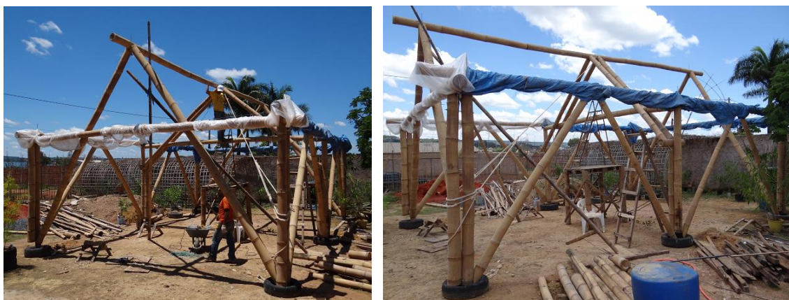
Figura 94 – Figura 94a: Colunas inclinadas de suporte da viga principal da cobertura.
