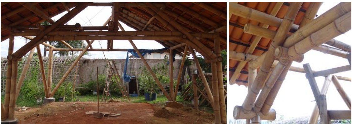
Figura 100 - Reforço estrutural do pórtico central. Fotos: Autor (2011).
