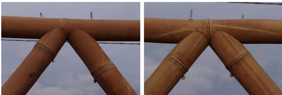
Figura 93 - União diagonal entre peças de bambu. Foto: Autor (2011).
