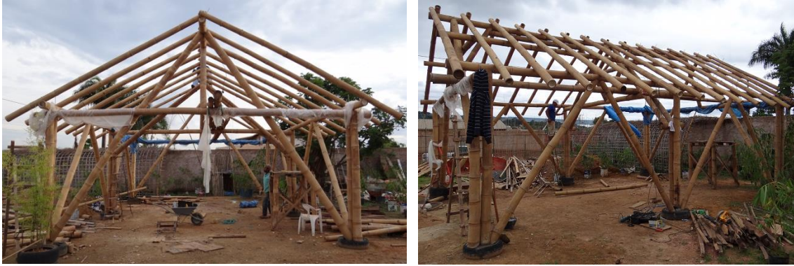
Figura 103 - Instalação dos caibros da cobertura. Fotos: Autor (2011).
