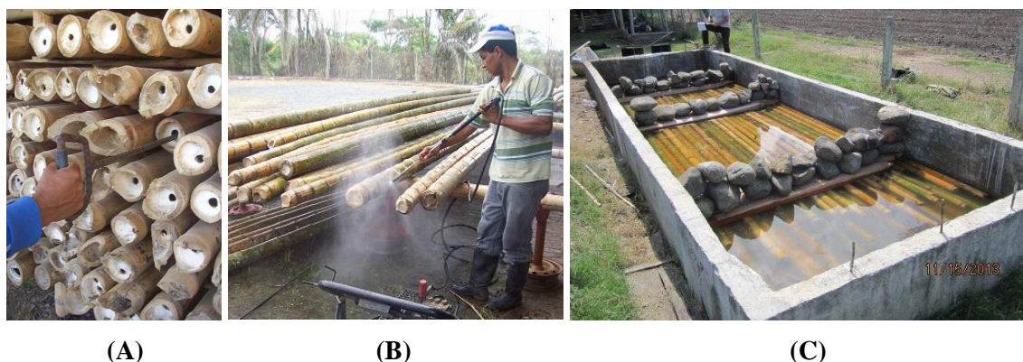
Figura 31 - Figura 31a: Perfuração dos diafragmas. Figura 31b: Limpeza de colmos de bambu com hidro lavadora. Fotos: Autor (2010). Figura 31c: Tanque de tratamento por submersão. Foto: Autor desconhecido.
