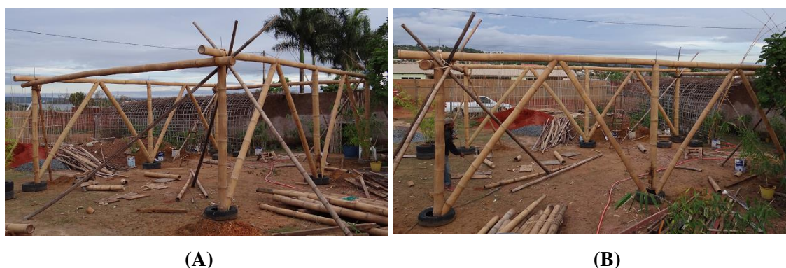
Figura 92 – Figura 92a: Peça de ligação entre pórticos laterais. Figura 92b: Travamentos dos pórticos laterais utilizando colunas inclinadas. Fotos: Autor (2011).
