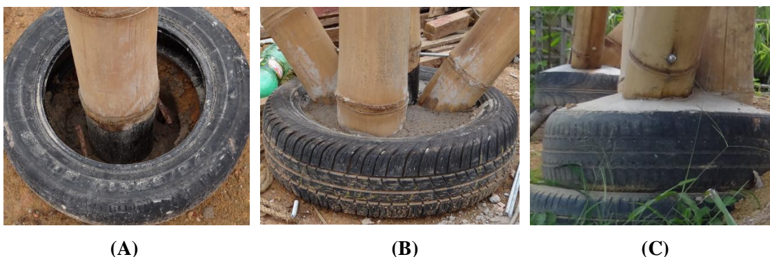
Figura 88 - Figura 88a: Coluna principal enterrada. Figura 88b: Concretagem do Pneu. Figura 88c: Acabamento da fundação. Fotos: Autor (2010).
