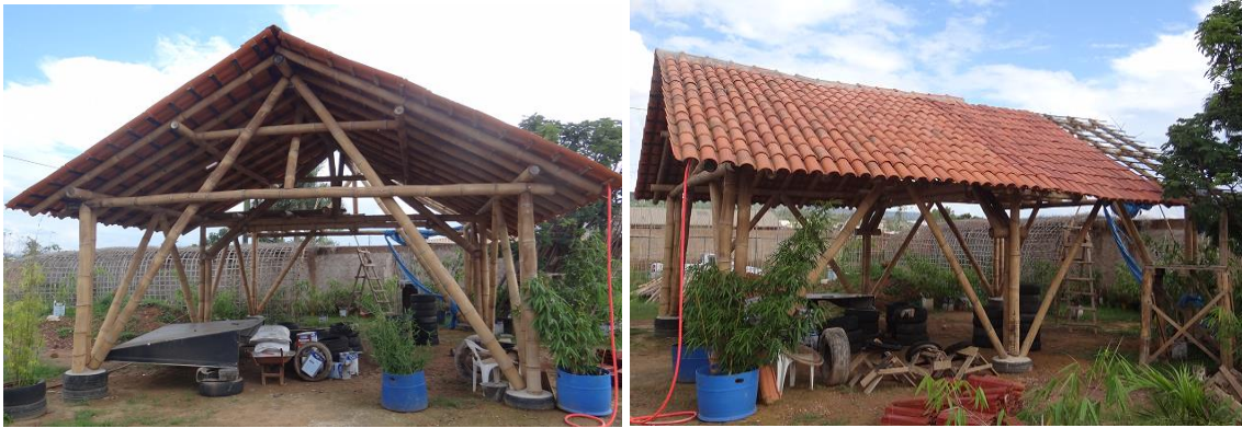
Figura 105 - Cobertura em telhas cerâmicas. Fotos: Autor (2011).
