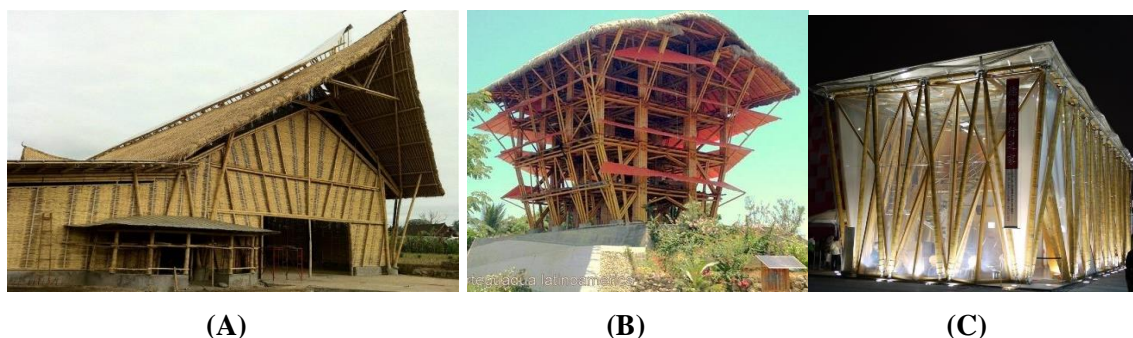
Figura 24 – Figura 24a: Fábrica de chocolate construída em Bali. Figura 24b: Estrutura desconhecida. Figura 24c: Pavilhão de bambu na Expo Shangai. Fonte: Internet (Endereços eletrônicos).
