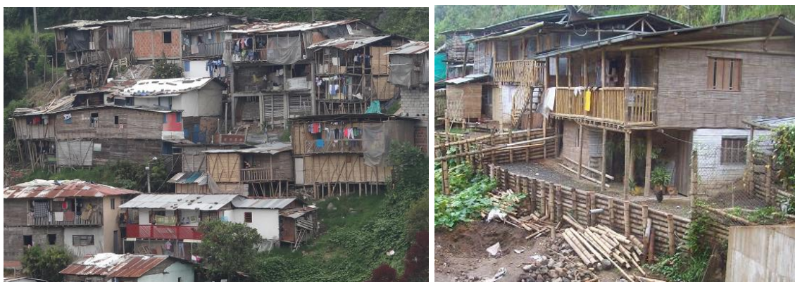
Figura 15 - Casas construídas com bambu em favelas e áreas rurais da Colômbia. Fotos: Autor (2015).
