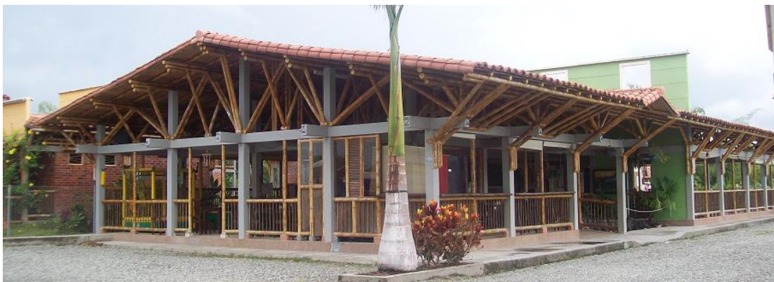
Figura 18 - Estrutura de concreto armado, estrutura da cobertura de bambu e telhas cerâmicas, na Colômbia. Foto: Autor (2010).
