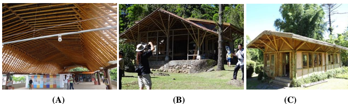
Figura 25 - Figura 25a- Centro de Cultura Max Feffer, Pardinihos/ SP. Figura 25b e 25c- Estruturas de bambu desenvolvidas pela arquiteta Celina Llerena, Mauá/ RJ. Fotos: Autor (2011).
