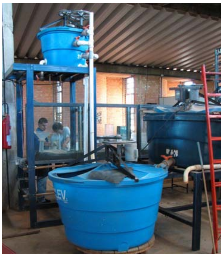
Figura H.3 – Sistema de armazenamento e mistura da lama
