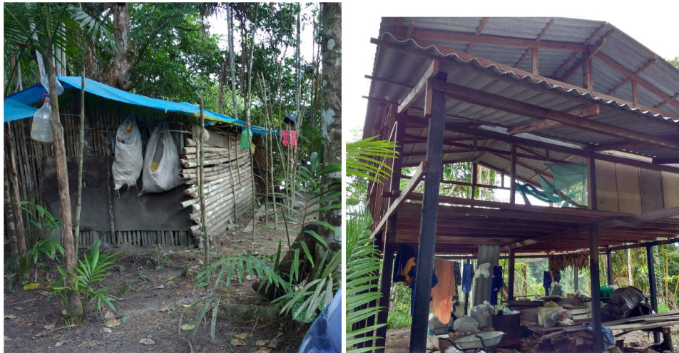
Figura 08 – Moradia anterior de comunitário da Bom Sucesso, antes da atividade de mutirão e atual moradia do comunitário (ainda em construção), após atividade de mutirão realizados por associados da Bom Sucesso.
