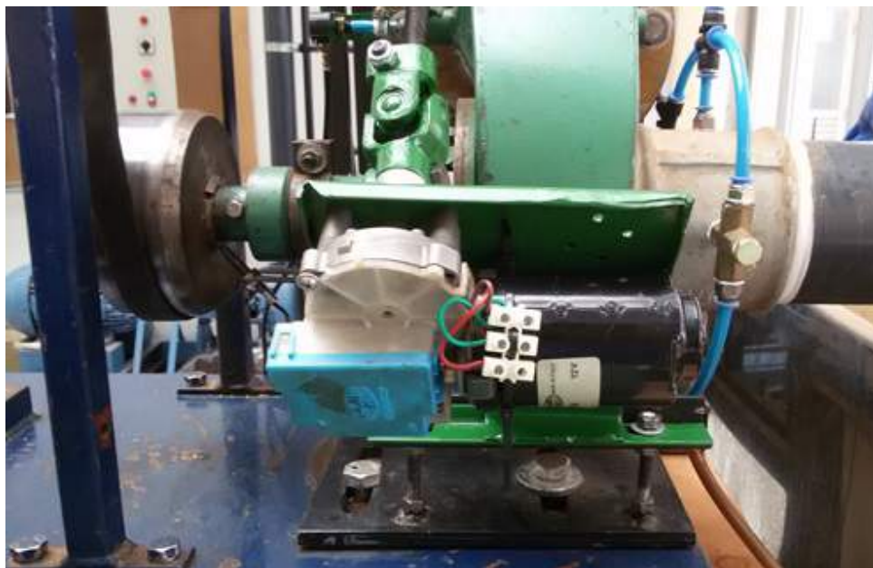
Figura 87 – Montagem do motor de acionamento para abertura e fechamento da válvula borboleta.
