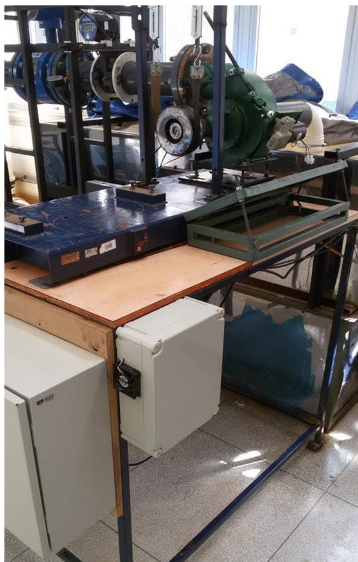
Figura 90 – Disposição final do quadro de comando do projeto - Quadro fechado.
