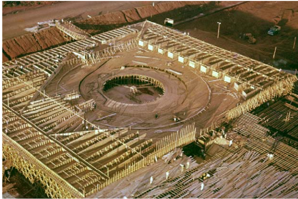
a) Construção do trecho do Senado, Edifício Principal
