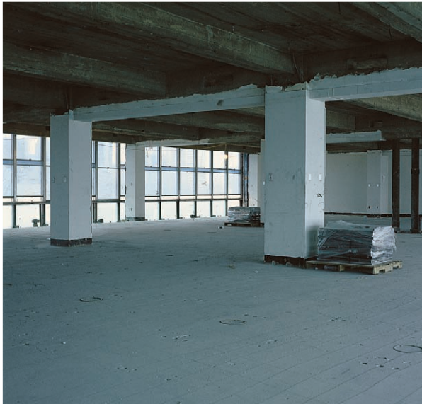
b) Pavimento-tipo após as demolições
