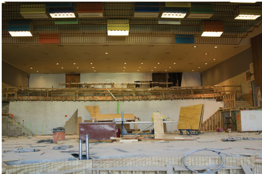
b) Durante as obras de renovação, 2012
