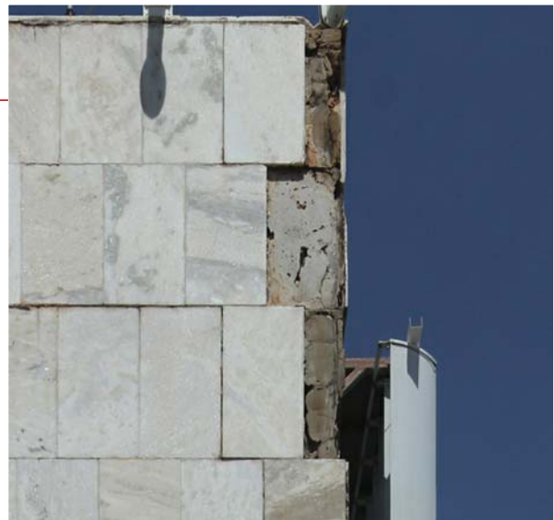
d) Trechos com desprendimento de peças Fonte: Costa 2014
