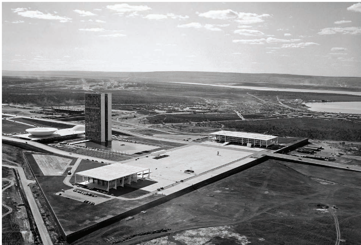
b) Palácios e a Praça dos Três Poderes finalizados
