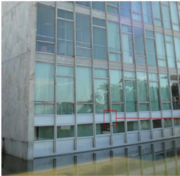
a) Cortina de vidro em aço das torres anexas, trecho
