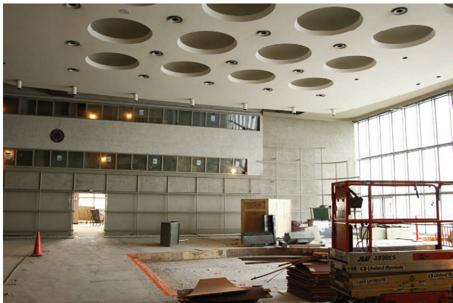
b) Durante as obras de renovação, 2012
