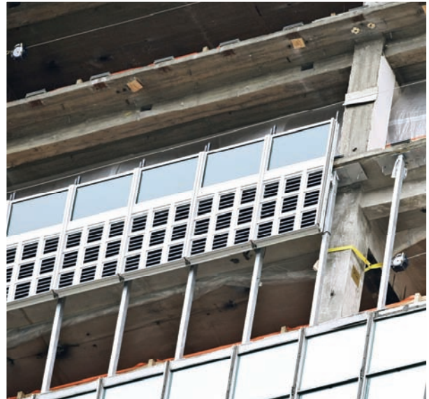
c) Montagem dos novos painéis da cortina de vidro
