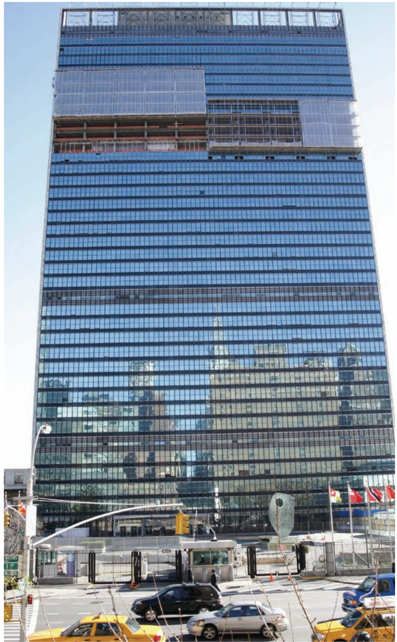
a) Execução a partir dos andares superiores, abaixo dos andaimes a original.
