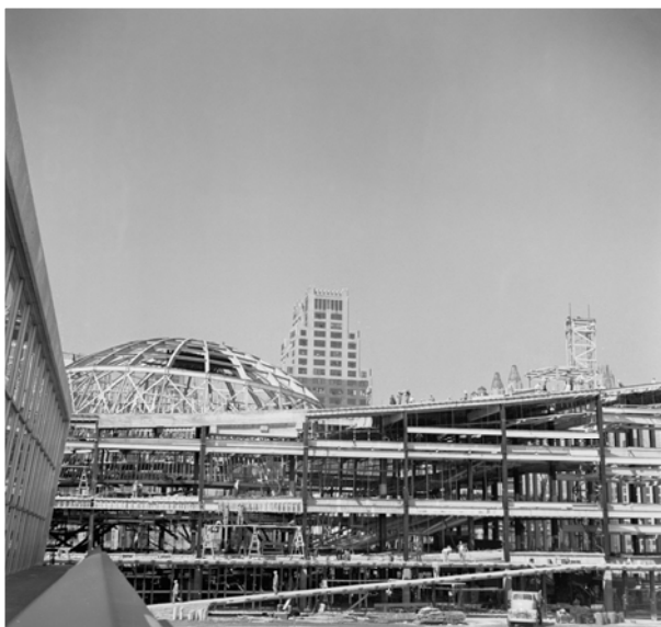
e) Estrutura metálica da Assembleia Geral
