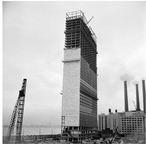
b) Construção do Secretariado
