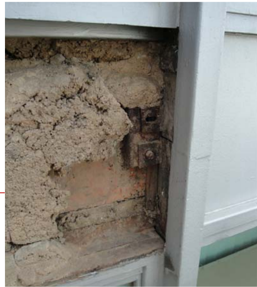
b) Cortina de vidro, montante e ancoragem
