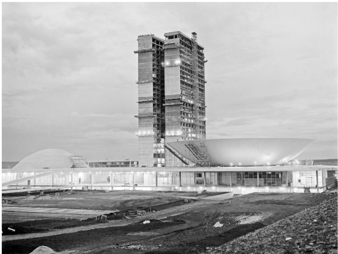
e) Fase de acabamentos no Edifício Principal e torres ainda em obras Fonte: Instituto Moreira Salles
