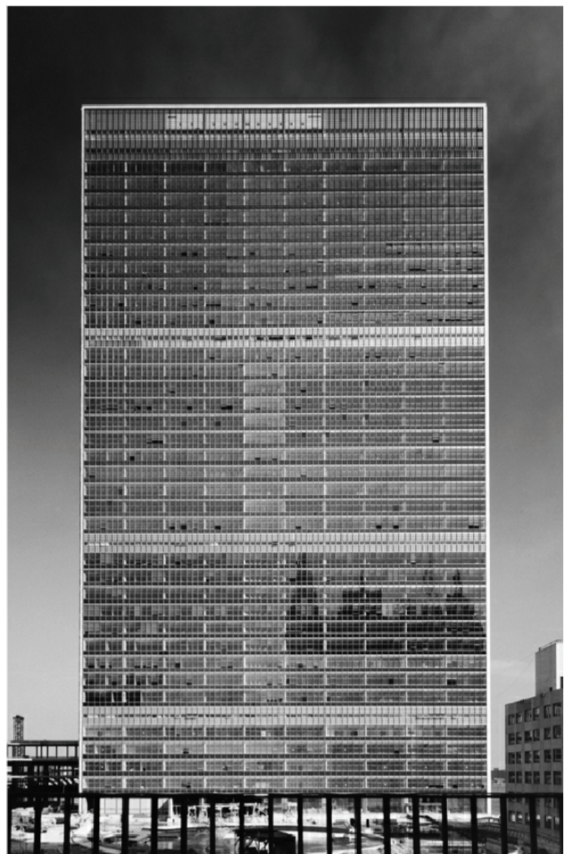
c) Edifício Finalizado
