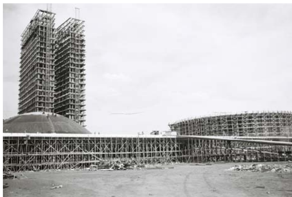
c) Montagem das torres anexas e cúpula da Câmara
