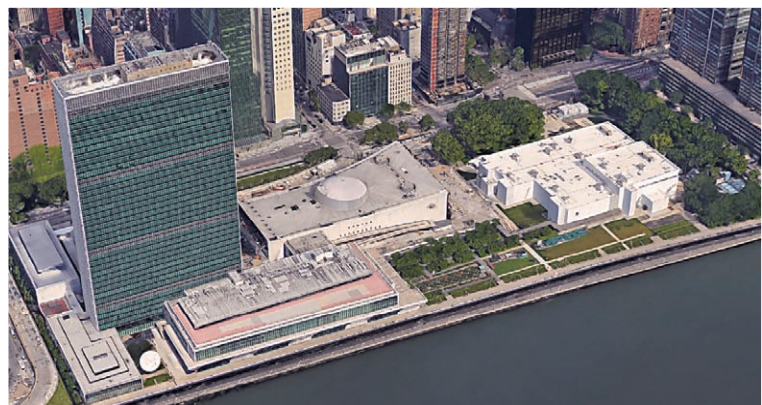
b) Bloco temporário construído. Após o plano de renovação foi desmontado, com restauração do paisagismo.
