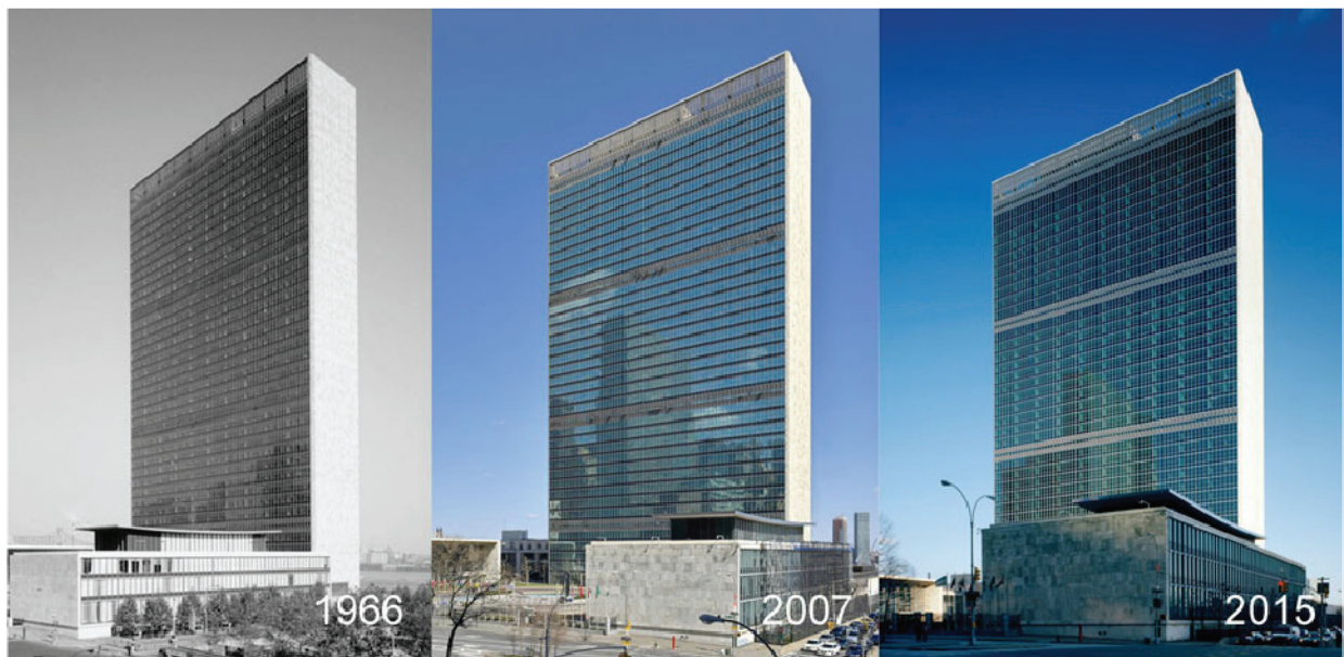
b) Comparação entre a feição da cortina de vidro, na década de 60, antes do plano de renovação e após a substituição.
