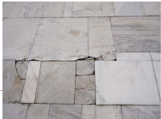
f) Trechos danificados por dilatação térmica do conjunto
