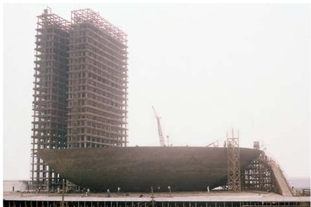
d) Cúpula e estrutura metálica das torres finalizadas
