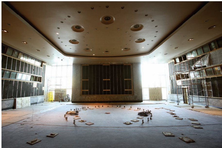
b) Durante as obras de renovação, 2012
