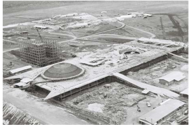
b) Início da construção das torres anexas
