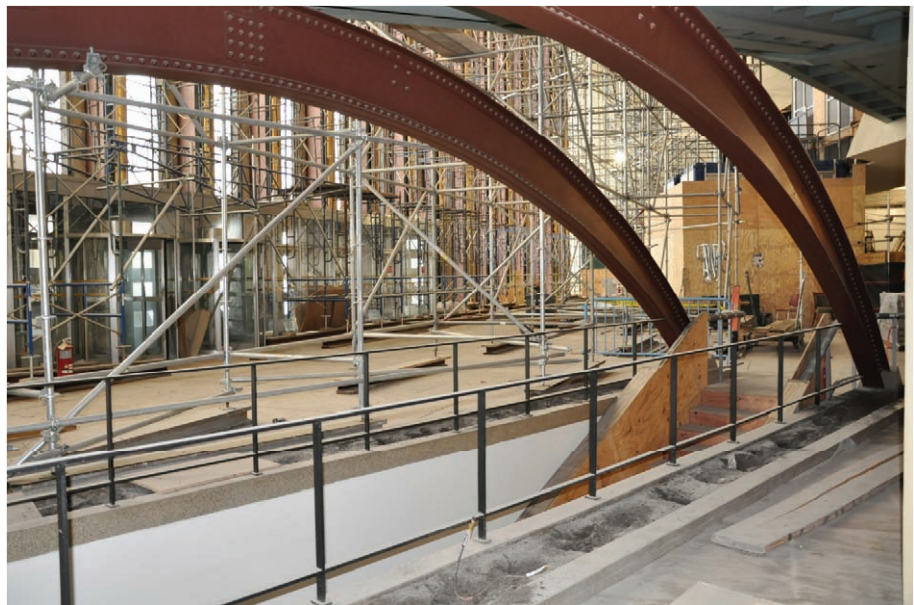
b) Durante as obras de renovação, 2013
