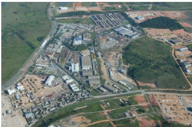
Figura 44 - Setor industrial 1 – Terminal de Cabiúnas- Macaé.
