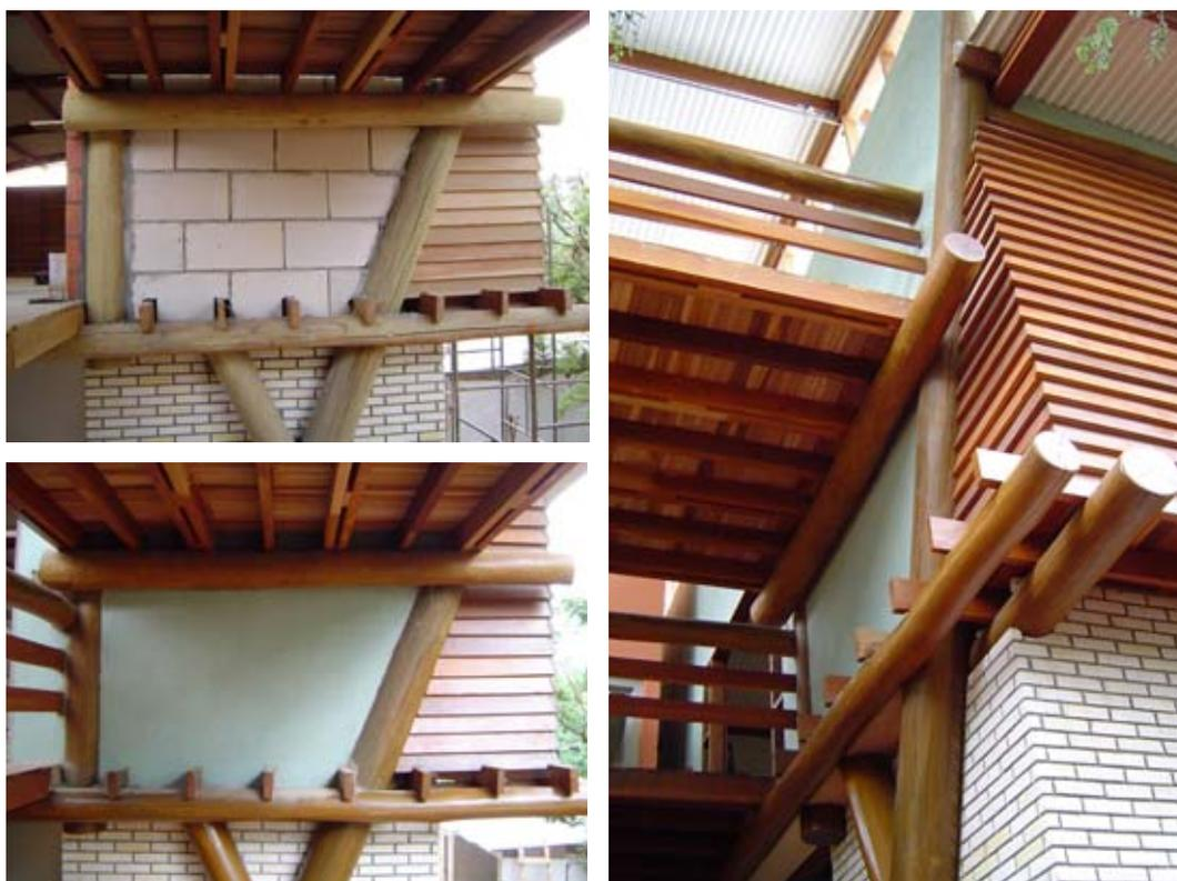
Figura 137 – O rigor da execução em madeira determinou esta alteração: o trecho de vedação, inicialmente projetado em madeira, foi executado em alvenaria, que não exige tanta precisão e se “molda” no espaço disponível. Fonte: MELLO (2006).
