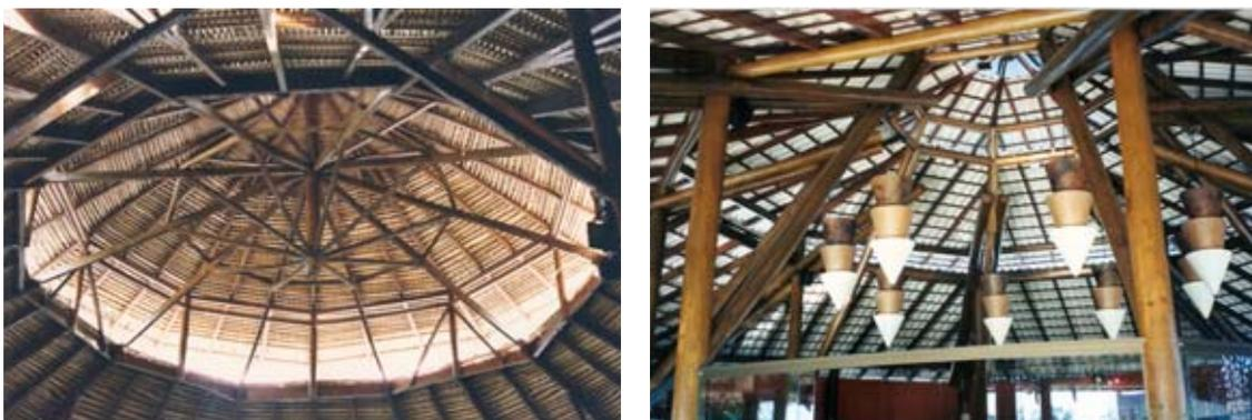
Figura 125 – Cobertura de edificação no Parque do Mindu, em Manaus (AM), e em restaurante em Caldas Novas (GO); as estruturas de madeira sobre plantas circulares remetem à arquitetura indígena. Fonte: MELLO (1998-2003).
