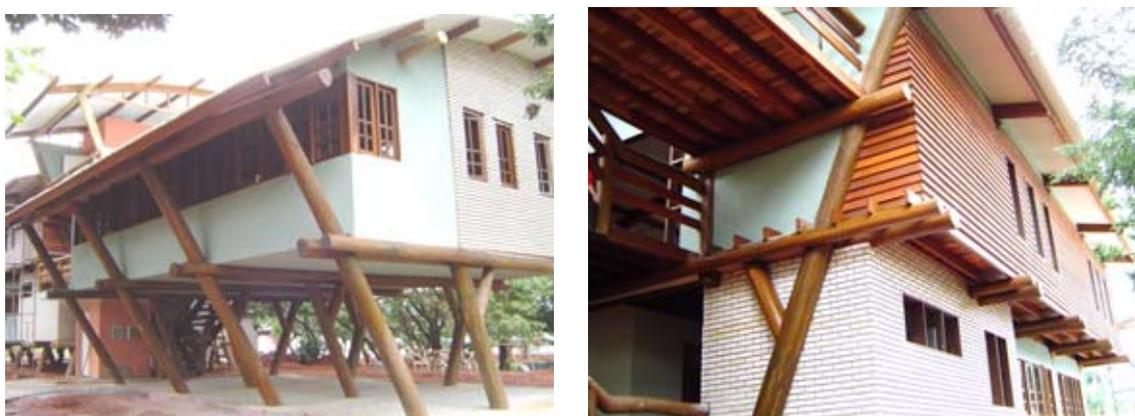
Figura 132 – Vistas externas do CENAFLOR, com as “caixas” de alvenaria e madeira apoiadas sobre a estrutura de madeira roliça. Fonte: MELLO (2007).
