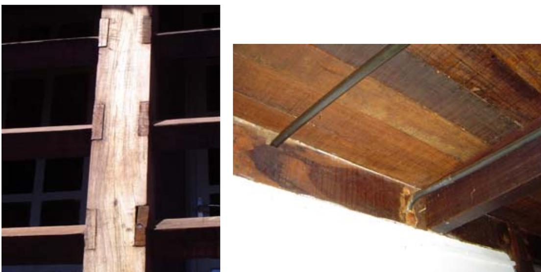
Figura 136 – Detalhe do encontro do pilar com peças do corrimão e passagem de tubulação sob o mezanino: o emprego do enxerto (“bacalhau”) demonstra a falta de observação do rigor exigido pela obra em madeira, que induz ao uso de soluções simplistas, resultando na desvalorização do edifício. Fonte: MELLO (2007).
