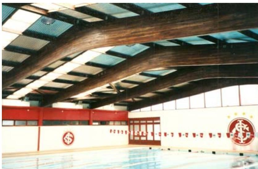
Figura 127 – Estrutura de cobertura de piscina olímpica em madeira laminada colada com vão de 20m, em Porto Alegre. Fonte: MELLO (2000).
