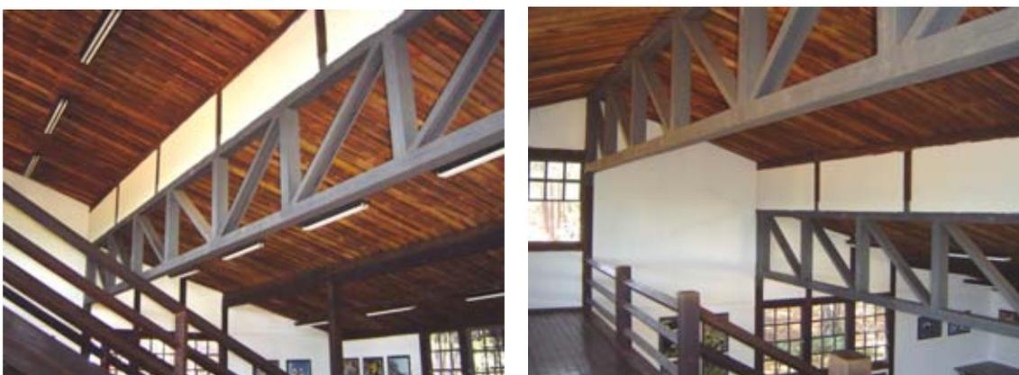
Figura 133 – A presença da estrutura treliçada metálica demonstra a limitação do sistema construtivo em relação à necessidade de grandes vãos livres. Fonte: MELLO (2007).
