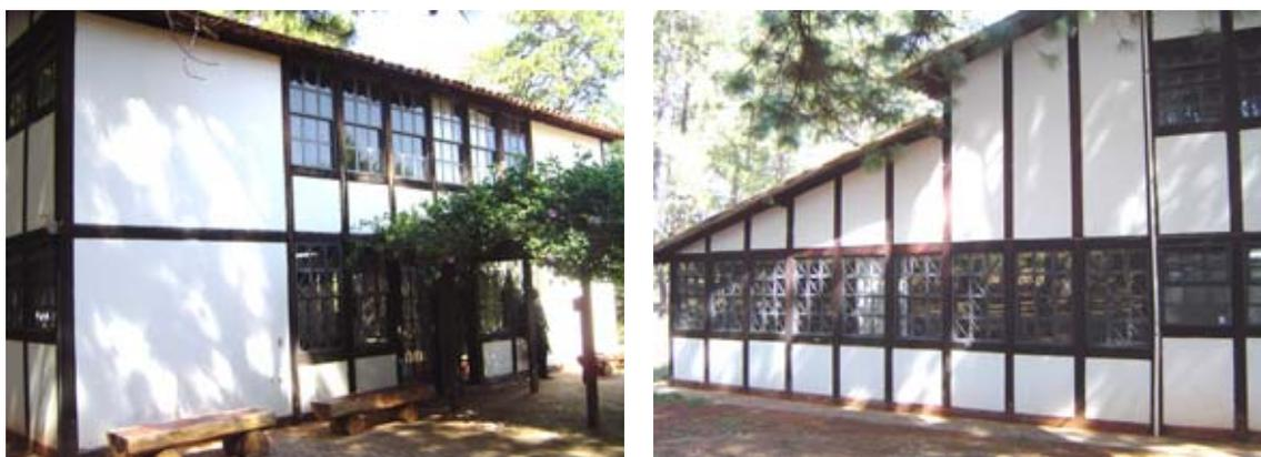
Figura 131 – Vistas externas do Centro de Visitantes do Jardim Botânico de Brasília, destacando o sistema construtivo em gaiola de madeira. Fonte: MELLO (2007).
