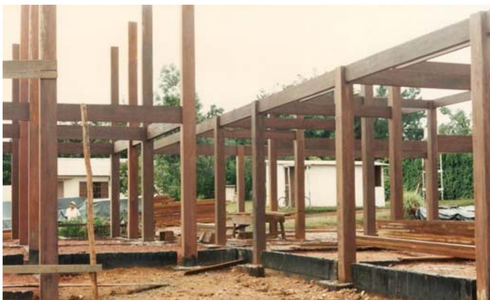
Figura 121 – Estrutura de madeira de residência em Brasília, com concepção mista entre gaiola e sistema pilar-viga, devido à existência de paredes fixadas pela trama e também paredes portantes. Fonte: MELLO (1995).
