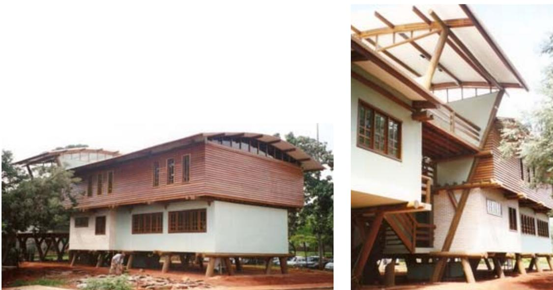
Figura 135 – O sistema estrutural se apresenta de forma diversificada nas fachadas, sugerindo ou expondo a solução construtiva do CENAFLOR. Fonte: MELLO (2006).
