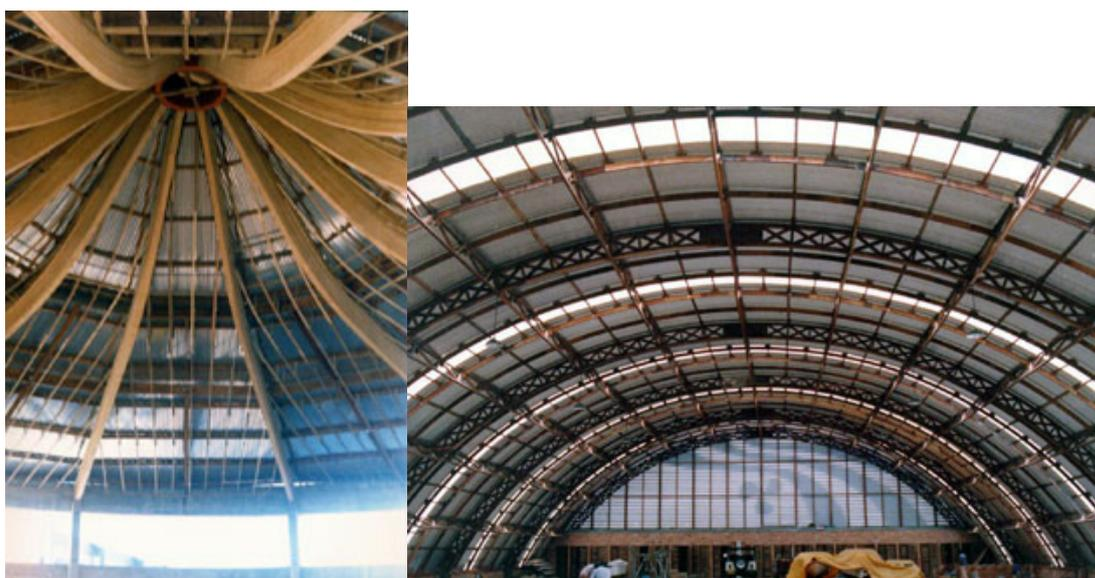
Figura 128 – Coberturas de teatro em Santa Catarina com madeira laminada colada e de hangar no Paraná com arcos treliçados de madeira. Fonte: EMADEL (2000).
