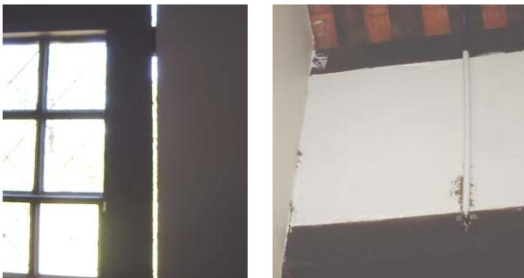
Figura 138 – Falta de detalhamento para soluções de amarração entre estrutura e vedações e de passagem de tubulações compromete e desvaloriza a edificação de madeira; no Centro de Visitantes as frestas permitem que a poeira e a água das chuvas invada os ambientes internos causando transtornos. Fonte: MELLO (2007).
