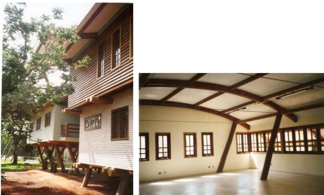
Figura 141 – Vistas externa e interna do CENAFLOR, onde se observa a integração entre arquitetura e estrutura que caracteriza e distingue as obras em madeira. Fonte: MELLO (2006).
