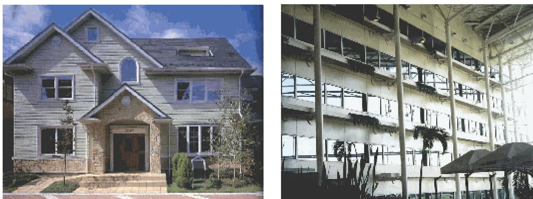
Figura 17 – Revestimentos de fachadas em residência no Japão e em galeria comercial em Londres utilizando chapas de cimento-madeira. Fonte: XS4ALL (2007).
