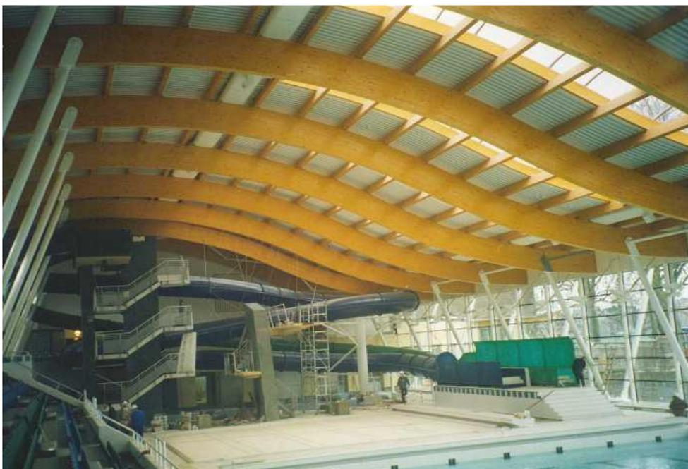
Figura 23 – Edificações no Canadá (foto superior) e na Inglaterra com uso de peças curvas de MLC. Fontes: CWC (2006) e AJASMITH (2006).
