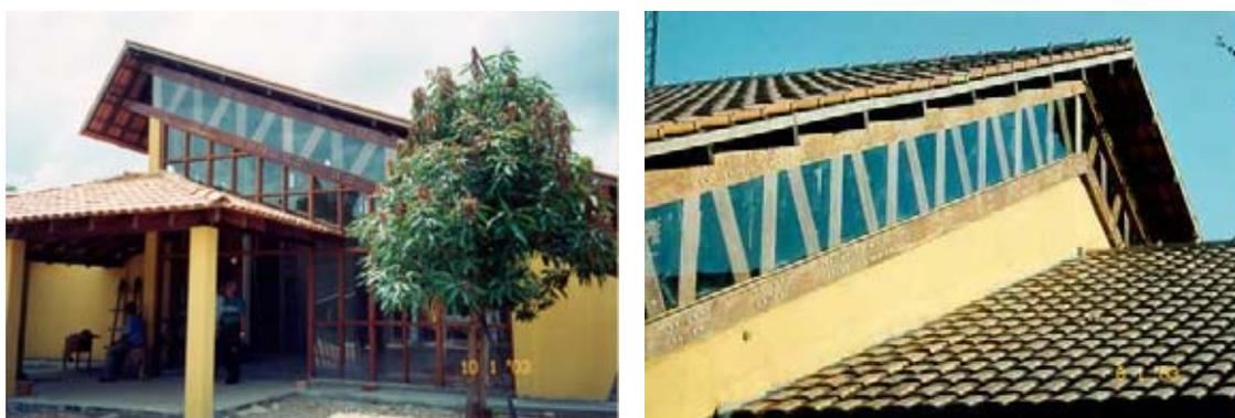
Figura 7 – Estruturas treliçadas de madeira amazônica no edifício-sede da superintendência do INCRA em Marabá – PA. Fonte: MELLO (2001).
