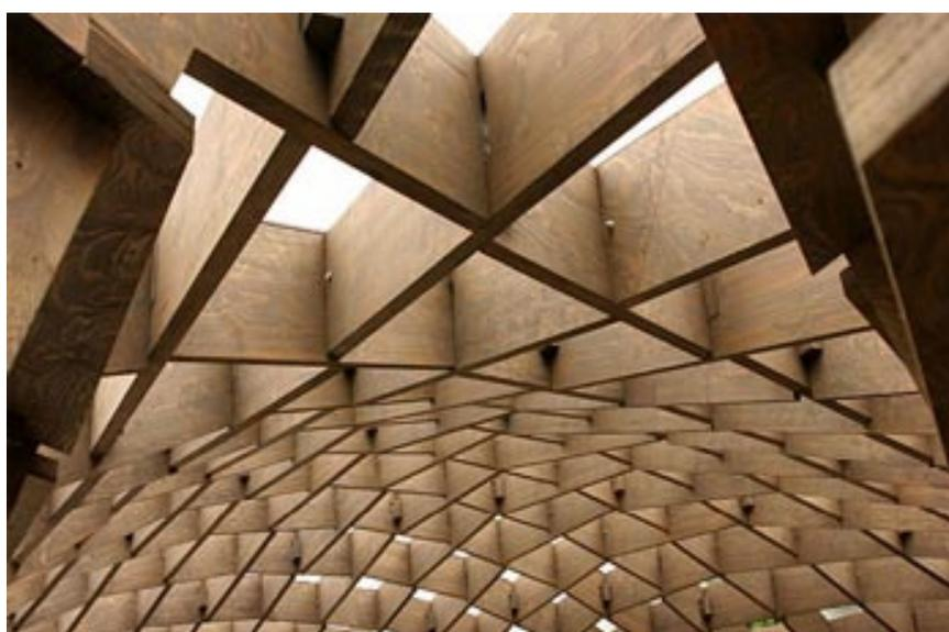
Figura 27 – Estrutura de LVL para abrigar a Galeria Serpentine em Londres, Inglaterra. Fonte: CONSTRULINK (2007).
