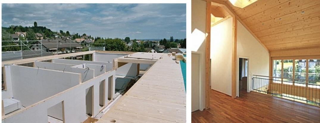
Figura 33 – Edificações com vedações e pisos em painéis autoportantes de compostos de madeira. Fonte: HOLZING-MAEDER (2004).
