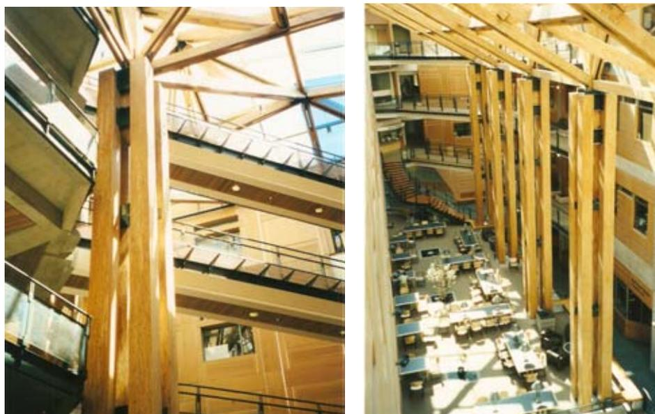
Figura 30 – Estrutura de edificação de 04 pavimentos em peças de Parallam, destinada à Faculdade de Ciências Florestais da Universidade da Colúmbia Britânica, em Vancouver, Canadá. Fonte: MELLO (2000).
