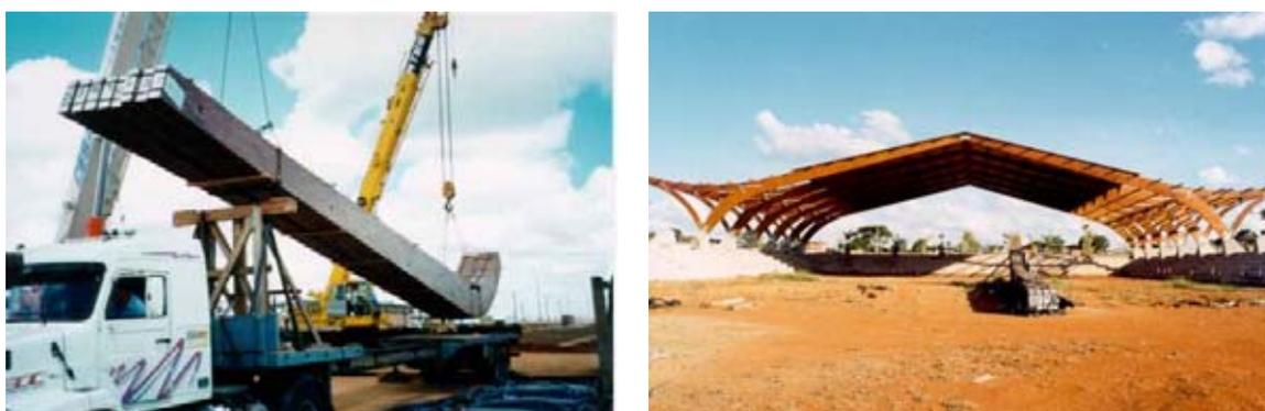
Figura 22 – Descarregamento de peças de MLC e execução de estrutura com vão de 48,00m no Parque de Exposições de Brasília. Fonte: MELLO (2000).
