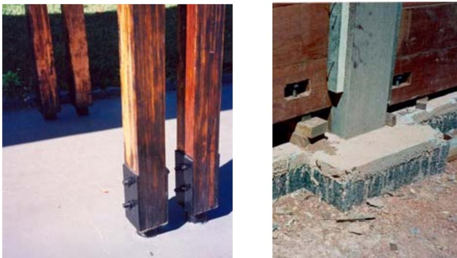
Figura 2 – Exemplos de pilar fixado com chapas e engastado em bloco de concreto. Fonte: MELLO (2003/2005).
