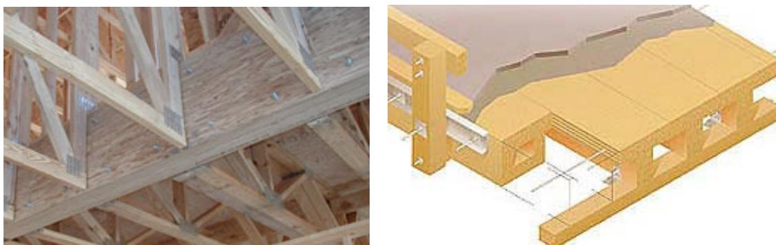
Figura 29 – Uso do Parallam em estruturas de cobertura e em módulo estrutural destinado a pontes. Fontes: TIMBERTRUSS (2005) e HUGHESBROS (2005).
