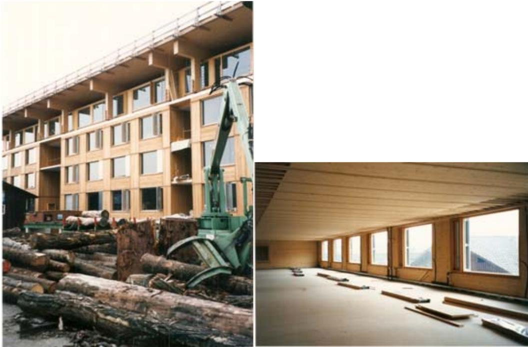
Figura 25 – Edificação de 05 pavimentos com estrutura plana de MLC destinada à Escola Técnica Federal da Madeira em Biel-Bienne, Suíça. Fonte: MELLO (1998).
