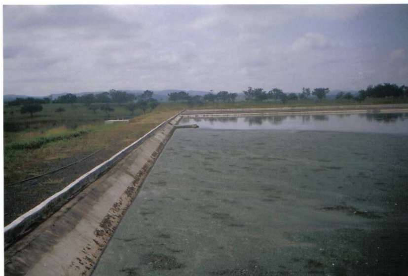
Figura 28 – ETE: lagoa facultativa e a formações dos tampões de matéria orgânica sus-pensa
