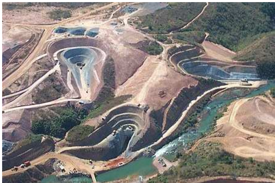
Figura 34 – Visão aérea da construção da Usina de Queimado
