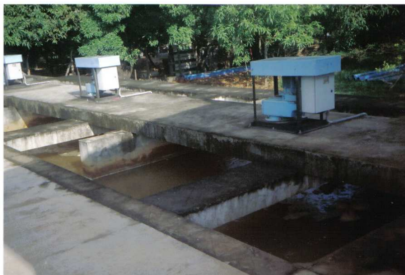
Figura 20 – Ação dos floculadores sobre a água – floculação
