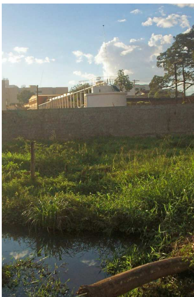
Figura 35 – Ponto de deságüe do esgoto da CAPUL no córrego Canabrava
