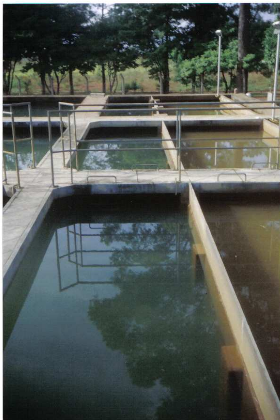
Figura 21 – Decantadores e o processo de filtragem da água
