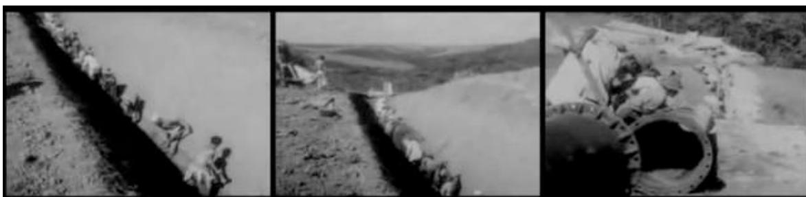
Toma a tela então a imagem de vários operários a cavar uma longa vala. Na imagem seguinte, eles empurram grandes manilhas de ferro, que rolam pelo terreno: *tubos para instalação da usina piloto de 600 cavalos para atender às emergências de construção, antes de se captar as águas do Paranoá.*
