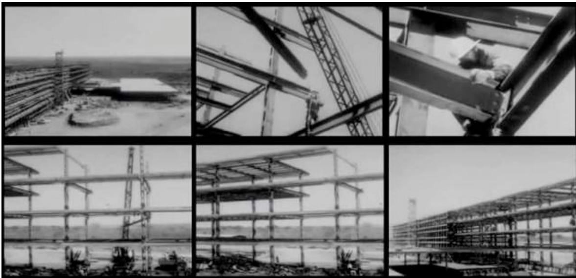
Chegamos agora, finalmente, a ver as obras de arquitetura em execução na capital. Uma imagem panorâmica do hotel em execução (Brasília Palace Hotel) é seguida pelo plano de um operário que encaixa uma imensa viga de aço, sustentada por um guindaste, na estrutura metálica do edifício. Seguem-se vários planos do esqueleto dessa estrutura.
