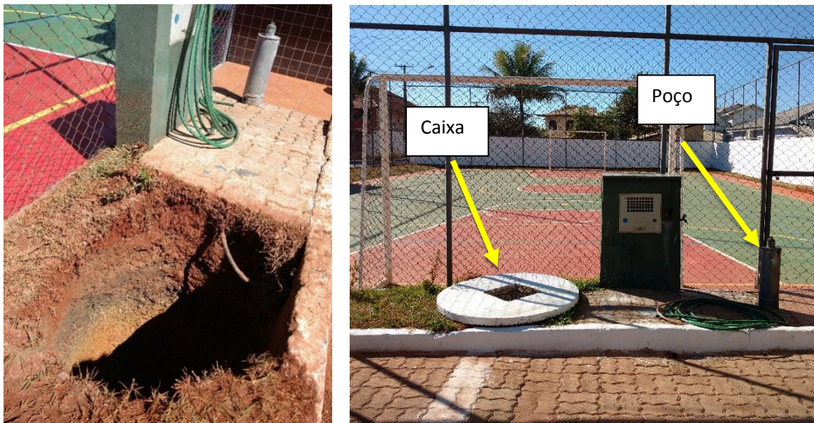
Figura 1.1 - Caixa de infiltração sem revestimento/preenchimento e depois de concluída. Condomínio San Diego.
