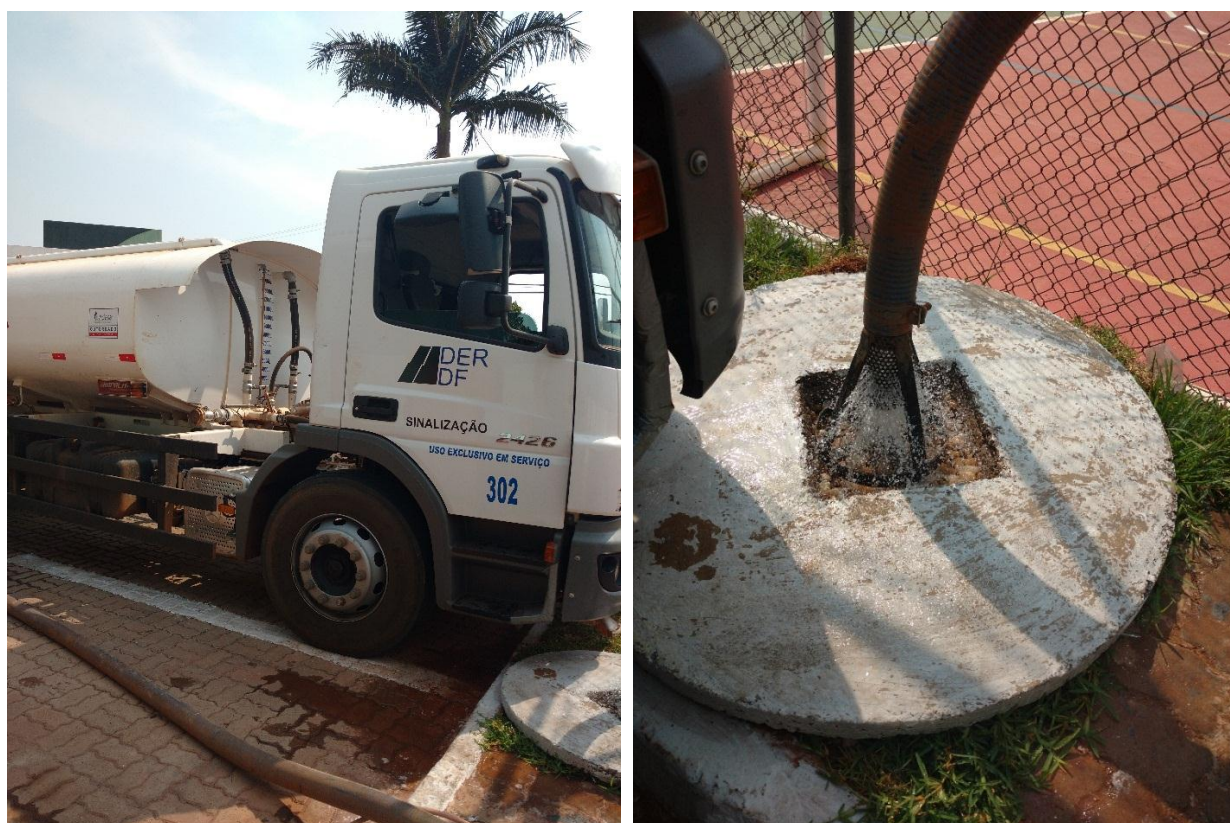
Figura 1.2 - Caminhão pipa utilizado e início da injeção de água na caixa de infiltração
