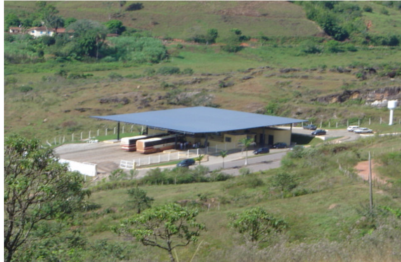
Fig. 2.24: Terminal Rodoviário de Conceição do Mato Dentro. (2005)
