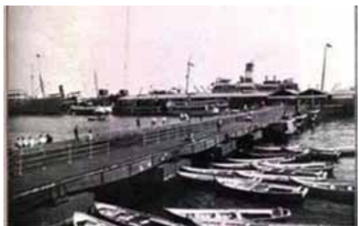
Primeiras edificações dos Armazéns Fonte: SEC – Secretaria de Estado de Cultura do Amazonas
