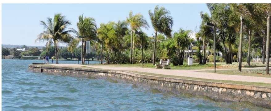
Figura 302: Muros de arrimo no Pontão do Lago Sul.
