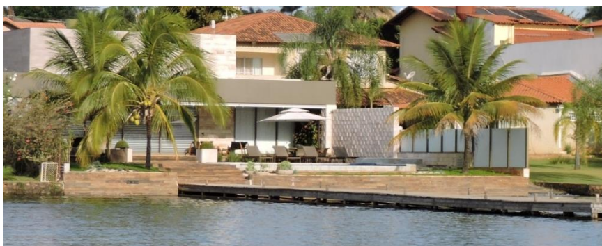
Figura 317: APP com solo impermeabilizado no condomínio Villages Alvorada.
