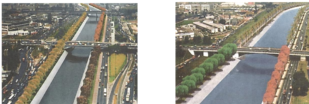
Figura 125 e Figura 126: Vista do Corredor Verde Tietê. Fonte: Vieira (2007, p.229 e 230).
