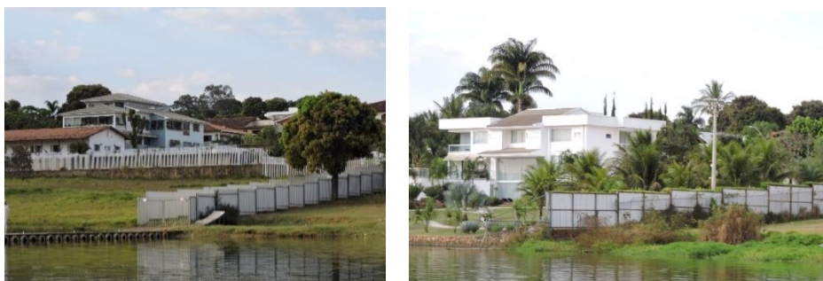
Figuras 357 e 358: Cercas metálicas separando os lotes na SHIN QL 04.
