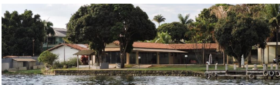
Figura 363: residências invadindo as APPs, na QL 10 do Lago Norte.
