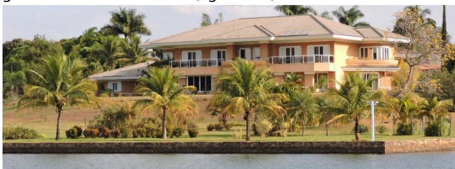
Figura 325: muro de arrimo para a contensão do solo na SHIS QL 09.
