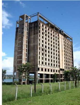
Figura 156: Esqueleto de um edifício de 50 metros de altura na orla do Lago Paranoá, a estrutura foi demolida no ano de 2007. Fonte: < skyscrapercity.com>, acesso em outubro de 2015.
