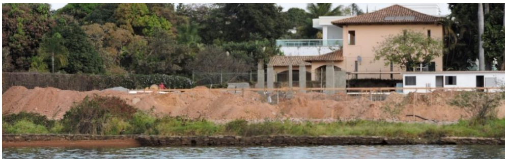
Figura 312: obras em parcela da SHIS QL 22.
