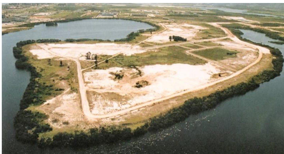
Figura 112: Vista da degradação na aérea do parque antes da sua implantação. Fonte: Chacel (2001, p. 50).
