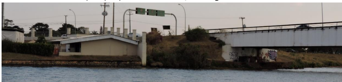
Figura 333: barreiras no Pontão do Lago Sul.
