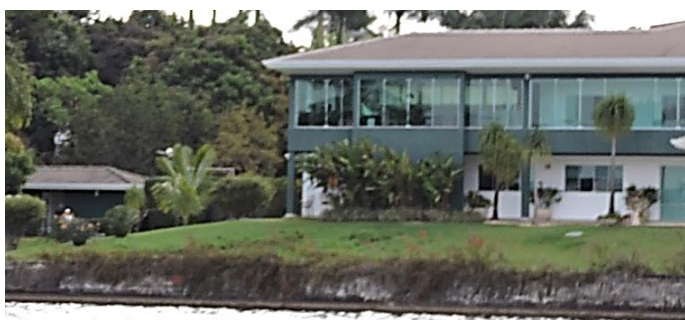
Figura 328: muros de arrimo na faixa de APP na SHIN QL 15 do Lago Norte.
