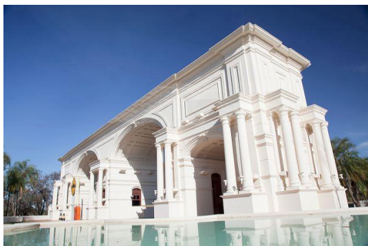
Figura 216: Pontão do Lago Sul: frontão romano. Fonte: disponível em <pontao.com.br>, acesso em novembro de 2015.
