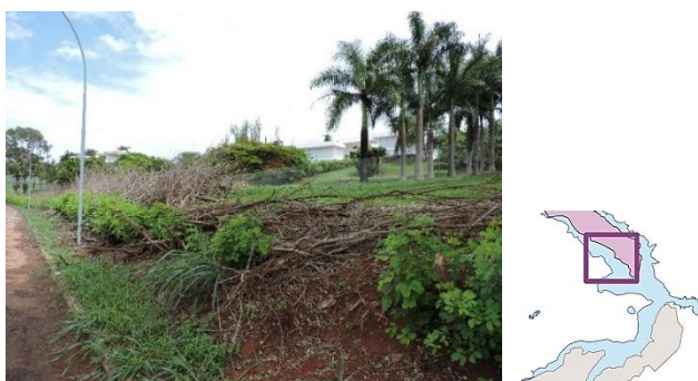
Figura 356: Cerca derrubada no Parque Ecológico Vivencial do Lago Norte.
