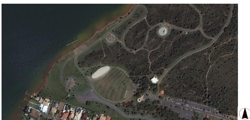
Figura 217: Vista aérea do Centro de Lazer Beira Lago. Fonte: Google Earth, 2015.
