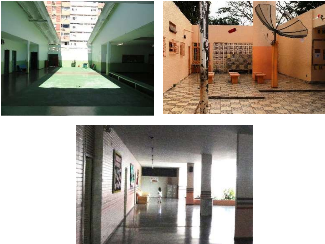
Figura 4.77– Acessos B (laterais) isolados na EC 312 Norte e EC 204 Sul e acesso A (frontal) isolado na EC 410 Sul
