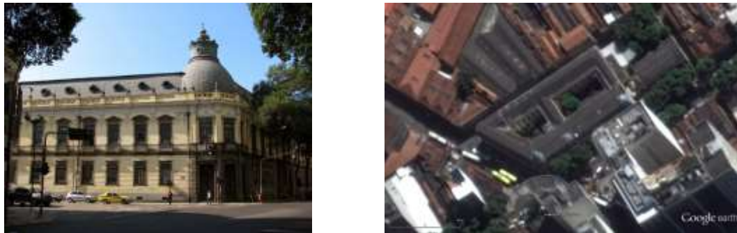
Figura 2.15 – Colégio Pedro II – Rio de Janeiro – vista e foto aérea Fonte: Google Earth acessado em 22.04.2015
