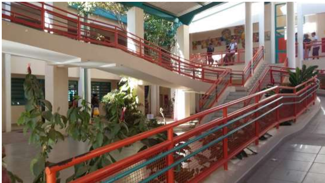
Figura 3.1 – Hall de entrada do Centro de Ensino Médio São Francisco (Chicão) São Sebastião – Distrito Federal Vista do portão de entrada do colégio
