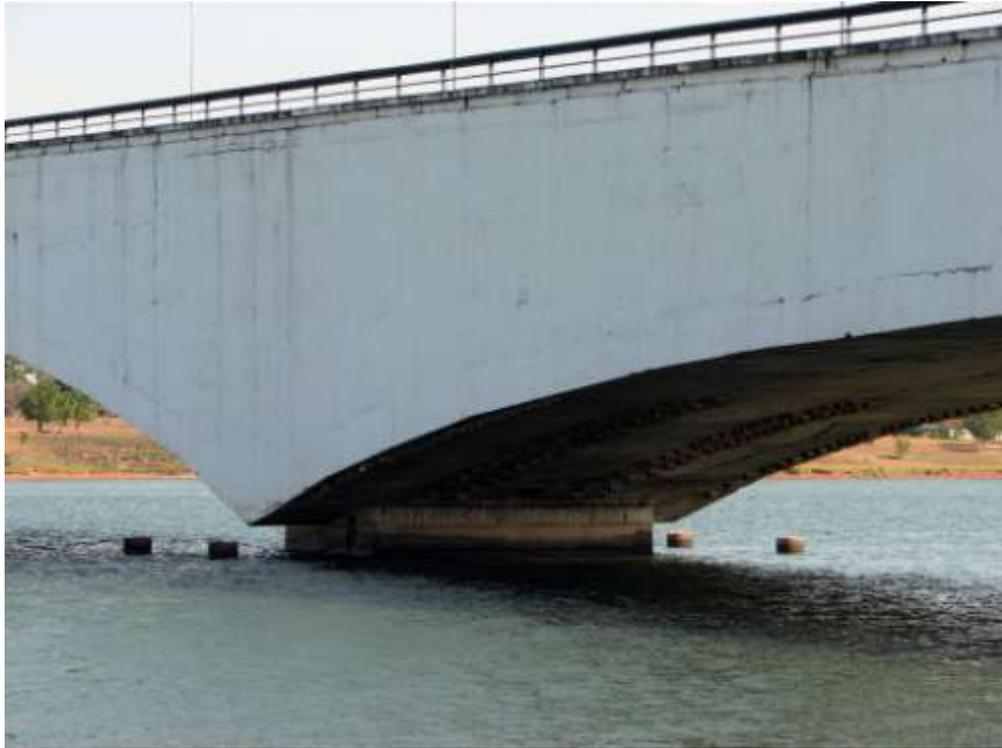
**Figura 4.18 – Ponte Costa a Silva, detalhes construtivos: bloco de fundação recuado e do reforço da fundação aparente em virtude do baixo nível de água do lago no período da seca. Fonte: (Foto do autor, 2007).**
