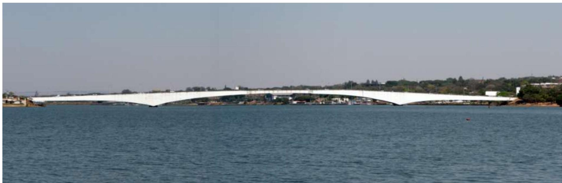
**Figura 4.13 – Ponte Costa e Silva no Lago Paranoá, visão frontal, notar os blocos de fundação recuados. Fonte: (Foto do autor, 2007).**
