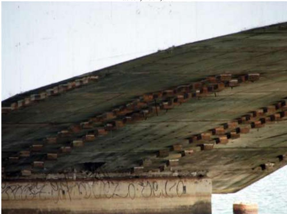
**Figura 4.19 – Ponte Costa e Silva, detalhes construtivos: cabos inclinados de costura, ver Figura 2.22. Fonte: (Foto do autor, 2007).**
