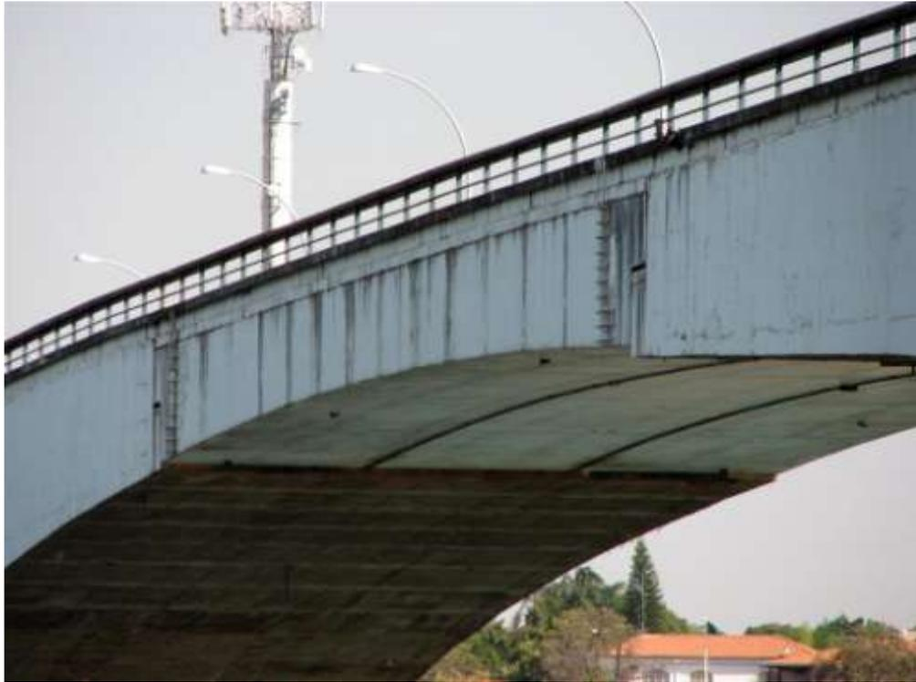
**Figura 4.20 – Ponte Costa a Silva, detalhes construtivos: trecho metálico comumente chamado de dente Gerber visão lateral. Fonte: (Foto do autor, 2007).**
