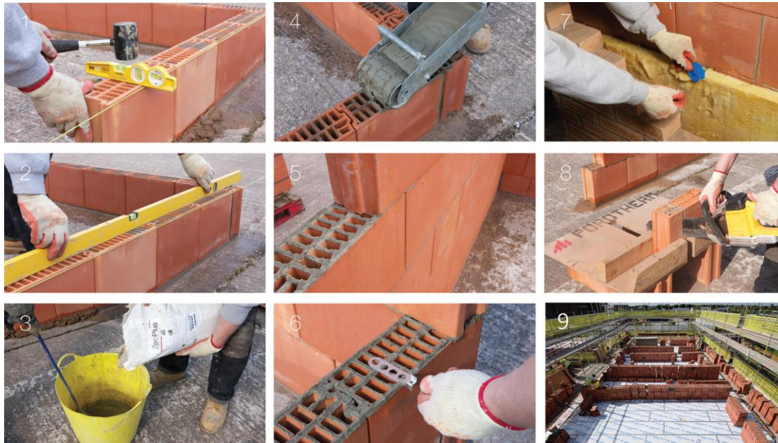
Figura 35: Processo de construção da vedação de bloco cerâmico. Fonte: Wienerberger, 2014
