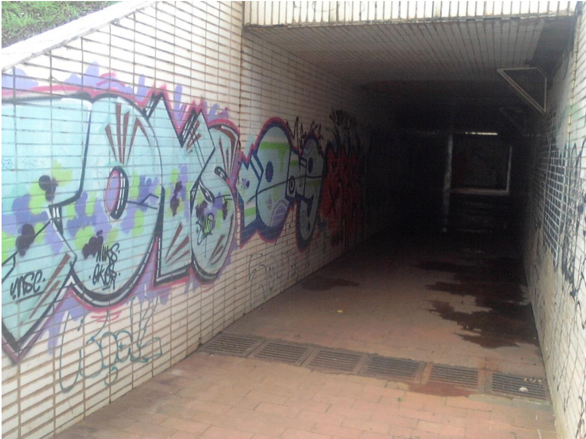
Figura 29. Passagens subterrâneas mesmo durante o dia são escuras. Foto: Marcel Vieira
