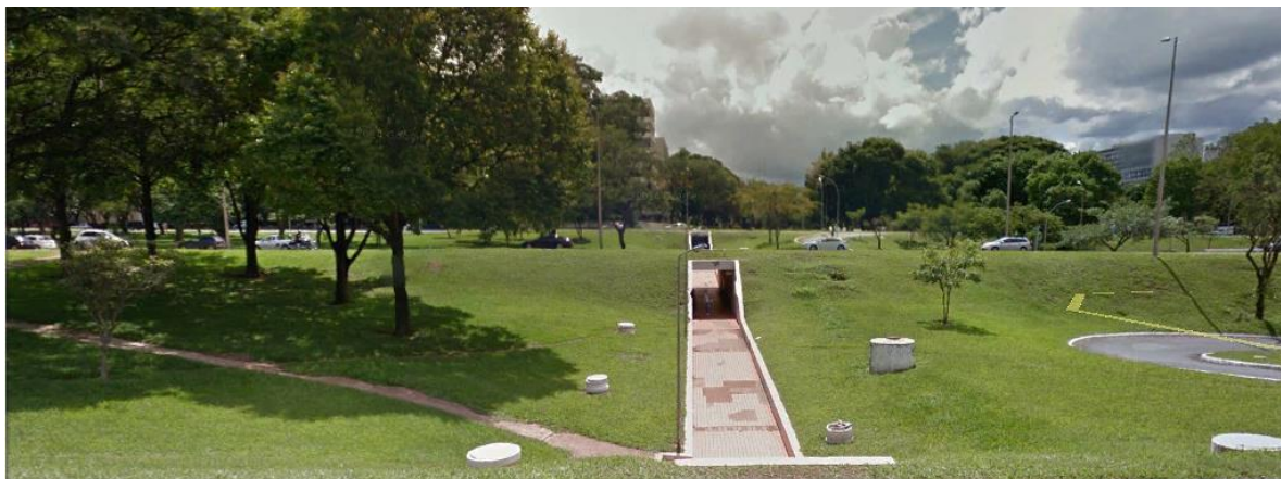
Figura 28. Situação do calçamento nas passagens. Imagem do Google Street View
