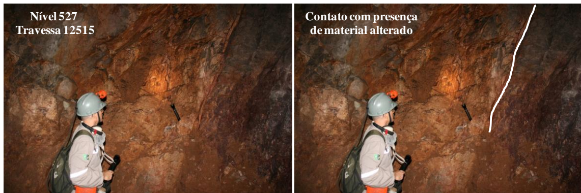
Figura D.36 – FV apresentando preenchimento com material alterado.
