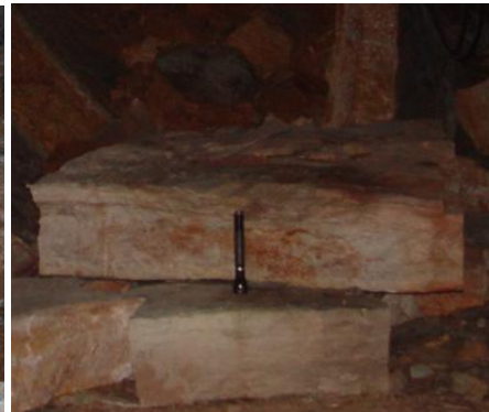
Bloco de rocha em forma de laje Galeria de transporte - nível 554
