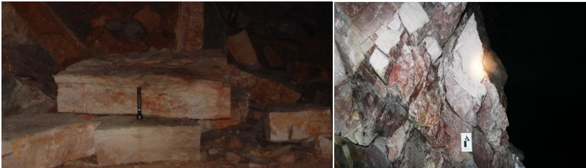
Bloco de rocha no dolomito rosa Galeria de transporte na capa – nível 554
