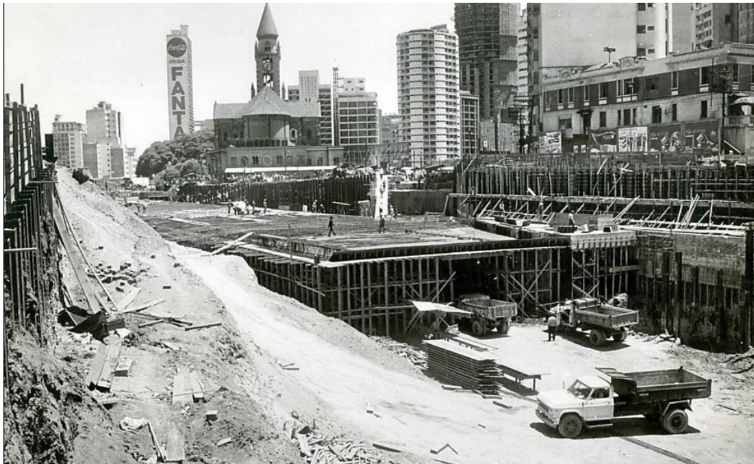
Figura 5 – Praça Roosevelt em Construção juntamente com a radial de ligação Leste-Oeste. Na imagem é possível visualizar a construção do túnel sobre o qual seria edificada a Praça Roosevelt. O mesmo túnel, apelidado de buraco da minhoca, desembocaria no elevador Costa e Silva, ou popularmente nomeado, Minhocão.
