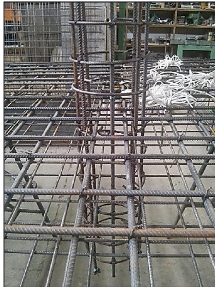
Figura 3.9 - Detalhe da armadura do pilar já posicionada
