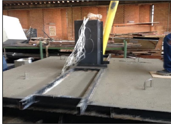
b) Surporte para fôrma do pilar
