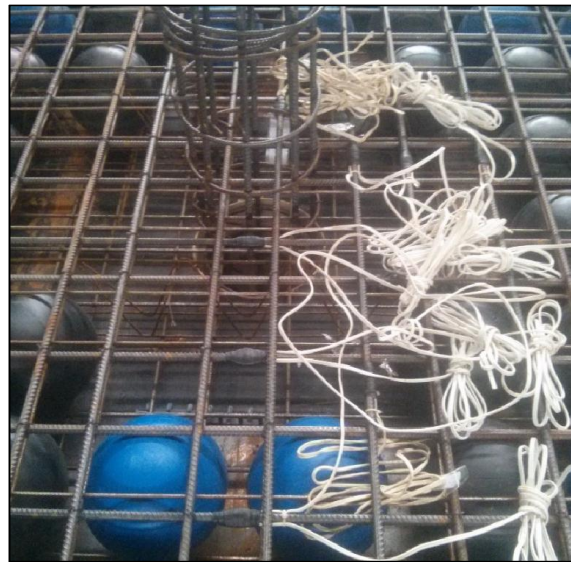
Figura 3.14 - Barras de flexão já instrumentadas
