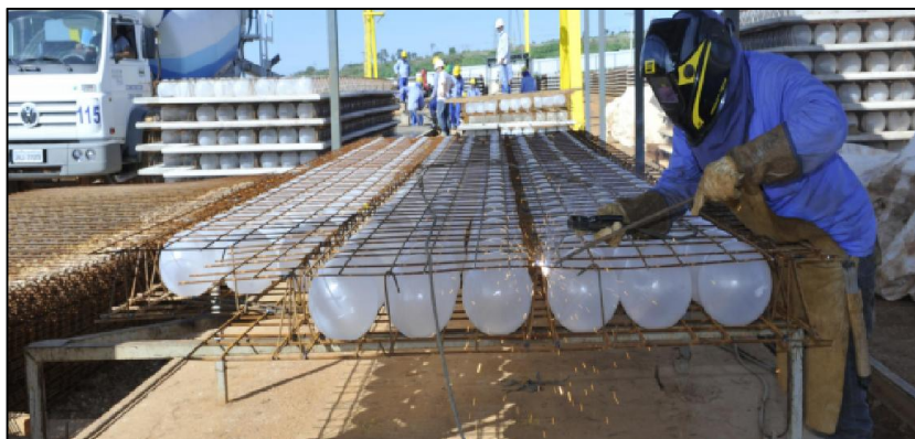
Figura 1.1- Montagem de laje tipo Bubbledeck ( Bubbledeck Brasil )
