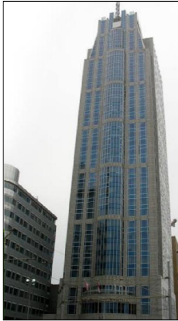
Figura 2.18 - Edifício Millenium Tower , Rotterdam, Holanda ( Bubbledeck Brasil , 2014)
