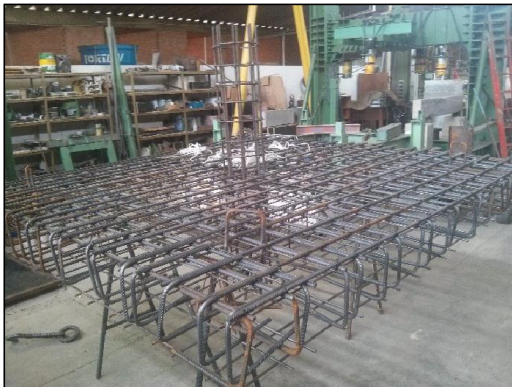
a) Armação da laje RSP.
