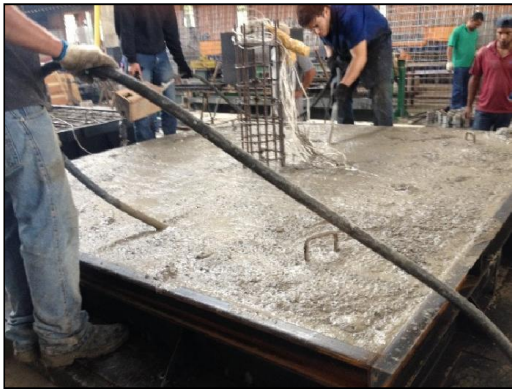
c) Durante a concretagem e vibração
