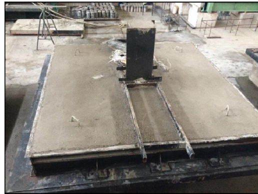
d) Acabamento das lajes
