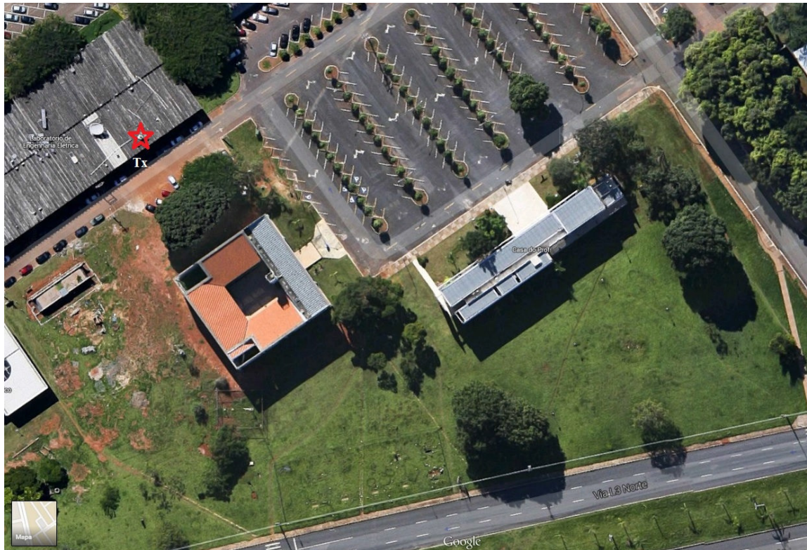
Figura 4.15: Vista aérea de um dos ambientes medidos
