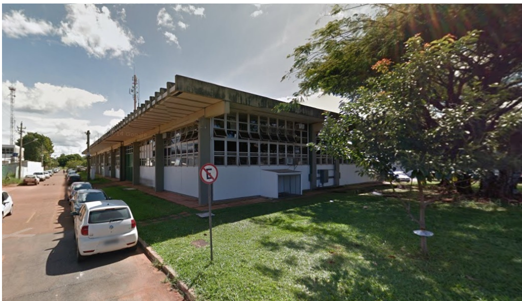
Figura 4.14 Prédio SG-11 UnB. Transmissor instalado no terraço.
