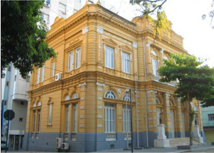
Ilustração 180. Edifício sob intervenção do Projeto do Centro Histórico.
