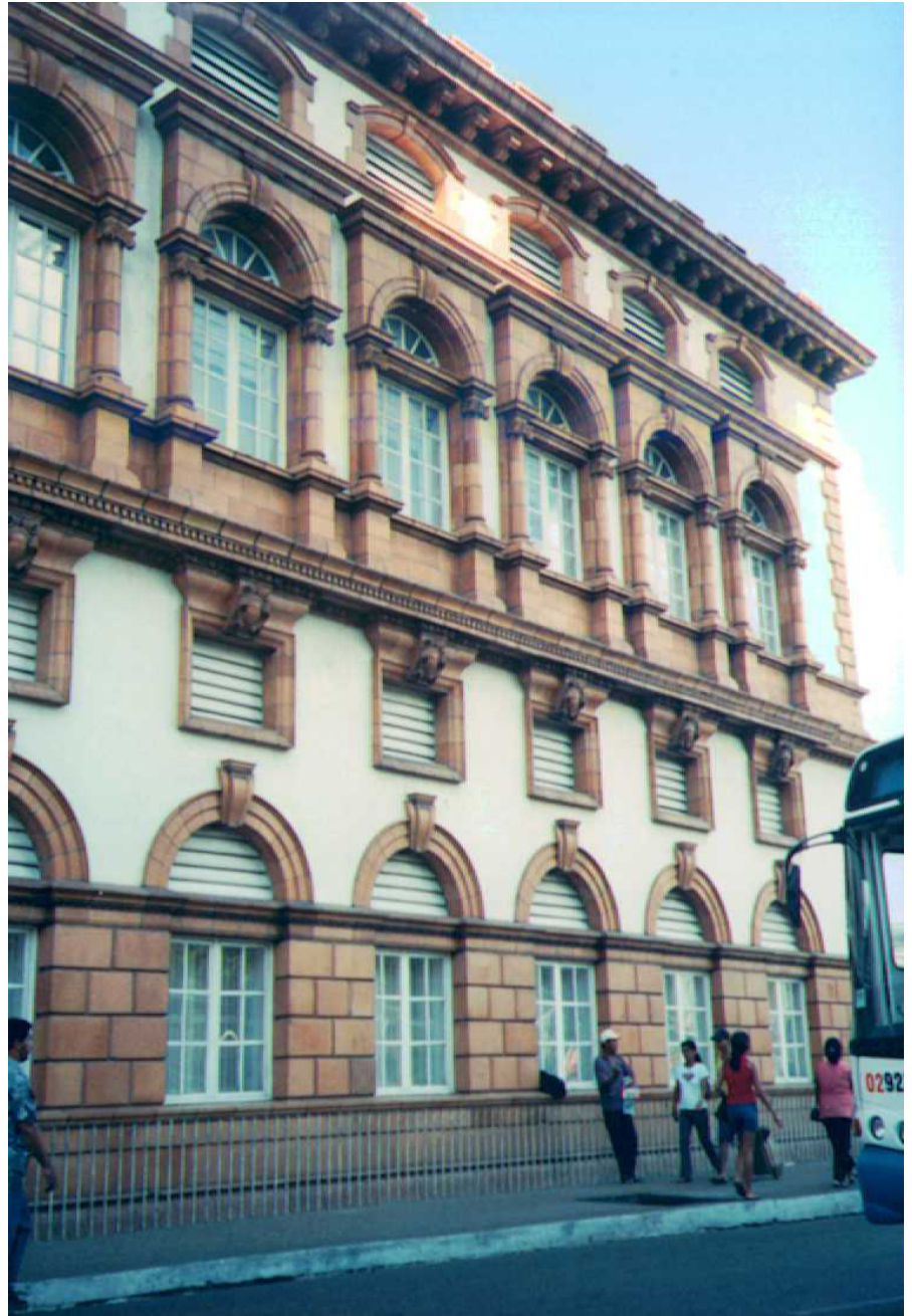
Ilustração 42. Fachada do Edifício da Alfândega. Autora: Graciete Guerra da Costa
