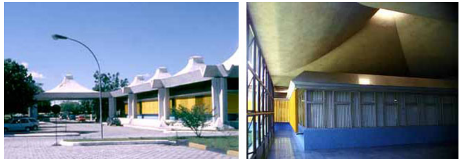
Ilustração 141. SUFRAMA - Sede da Superintendência da Zona Franca de Manaus. Autor: Arq. Severiano Mário Porto. Fonte: www.manaus.am.gov.br
