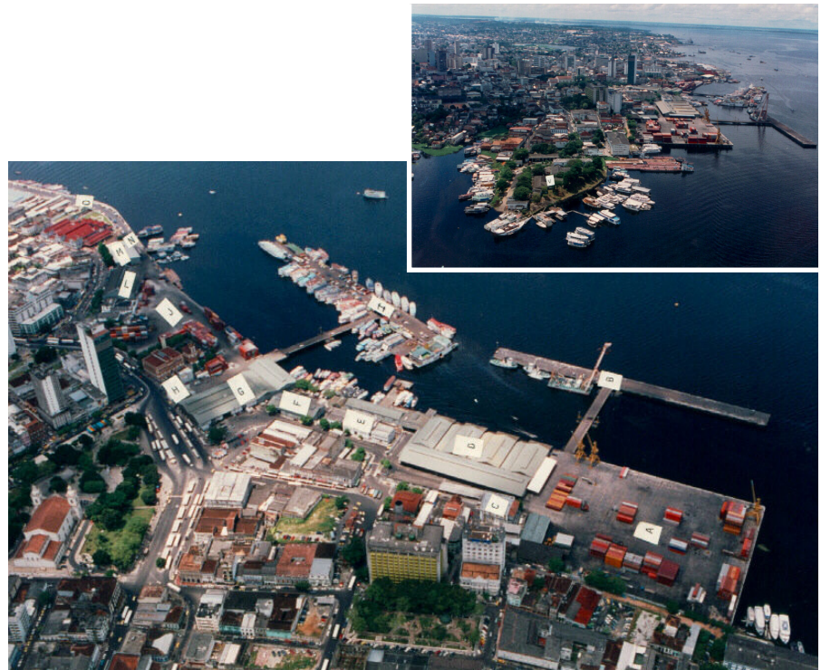
Ilustração 40. Vistas aéreas dos Armazéns do Porto. Autor: SEC - Secretaria de Estado de Cultura do Amazonas Fonte: www.culturamazonas.am.gov.br .
