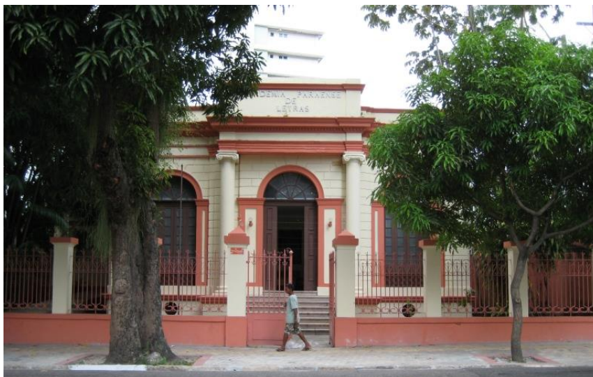
Edifício onde funcionou o Museu Paraense a partir de 1890 (Belém/PA) em 2014 31
