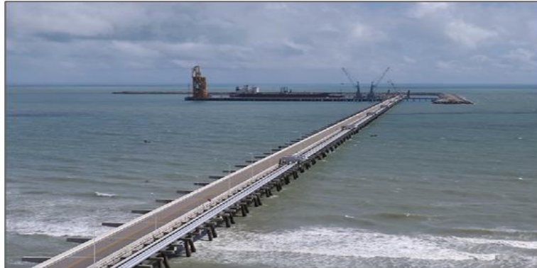
Figura 6.6: Ponte de Acesso
