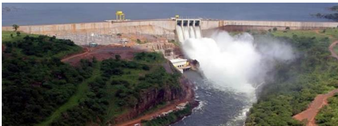
Figura 6.1: Barragem de Capanda, visto da jusante para montante.
