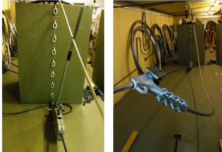
Figura 2 – Talha de alavanca ancorada ao bloco fixo 1.
