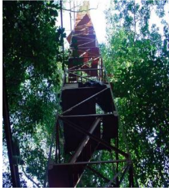
Figura III-9. Torre SIN, localizada no sítio experimental da UFMT em Sinop (MT).
