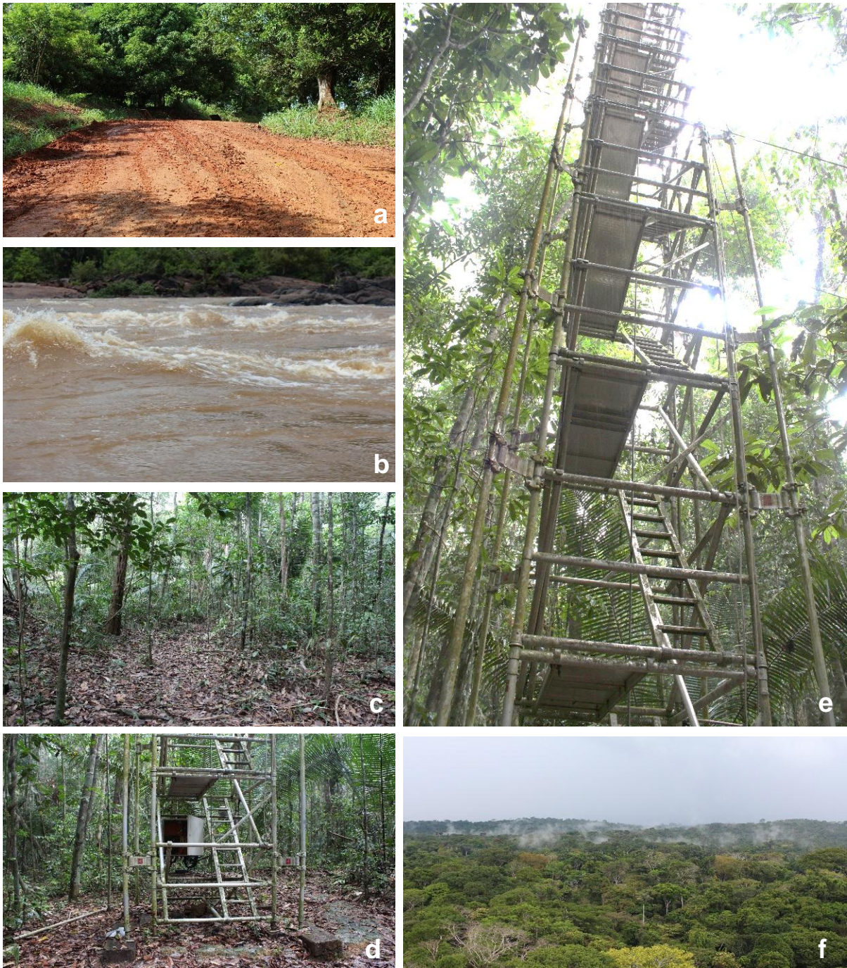
Figura III-16. Torre JAR do Programa LBA. a) estrada de acesso à torre; b) acesso pelo rio Jaru; c) trilha de 1500m; d) base da torre e equipamentos; e) torre JAR com 62 metros de altura e f) vista do dossel da floresta densa.
