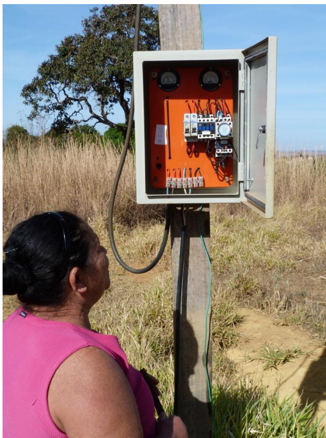
Figura 25: Quadro de luz para ligar a bomba do poço artesiano.
