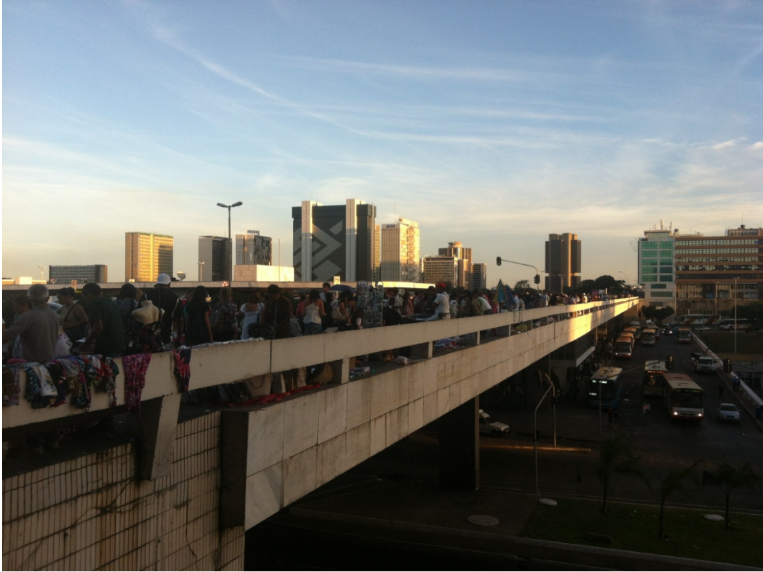
Fig. 43 – Calçada da Plataforma Rodoviária. Foto: Rogério Rezende
