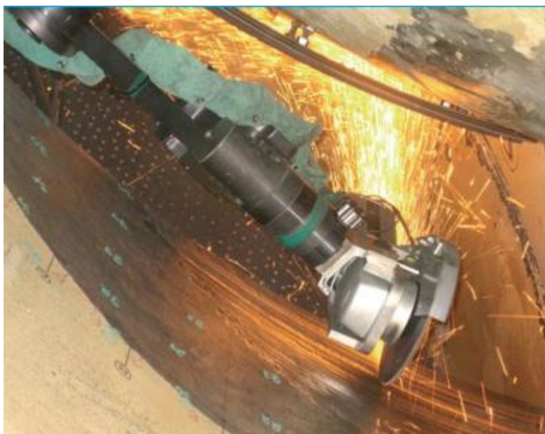
Figura 2.38 – Manipulador do robô Scompi executando tarefa de esmerilhamento (HYDRO QUEBEC, 2011)
