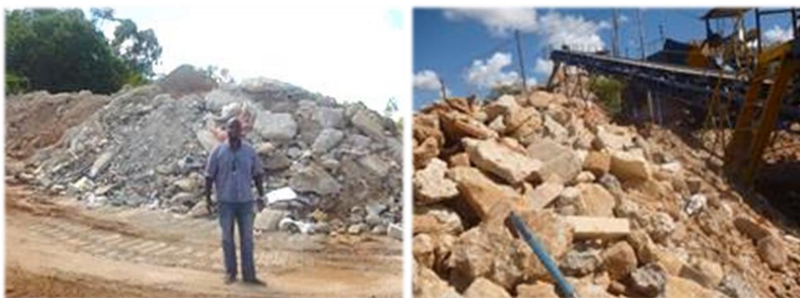
Figura 3.2 Entulho gerado da demolição do Estádio Mané Garrincha. Pátio de armazenamento da empresa Areia Bela Vista.
