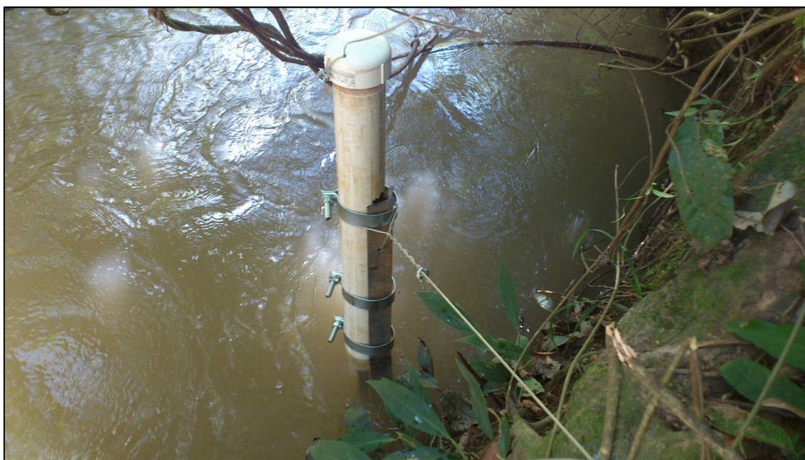
Figura 10 – Estrutura montada para fixação e proteção da sonda.
